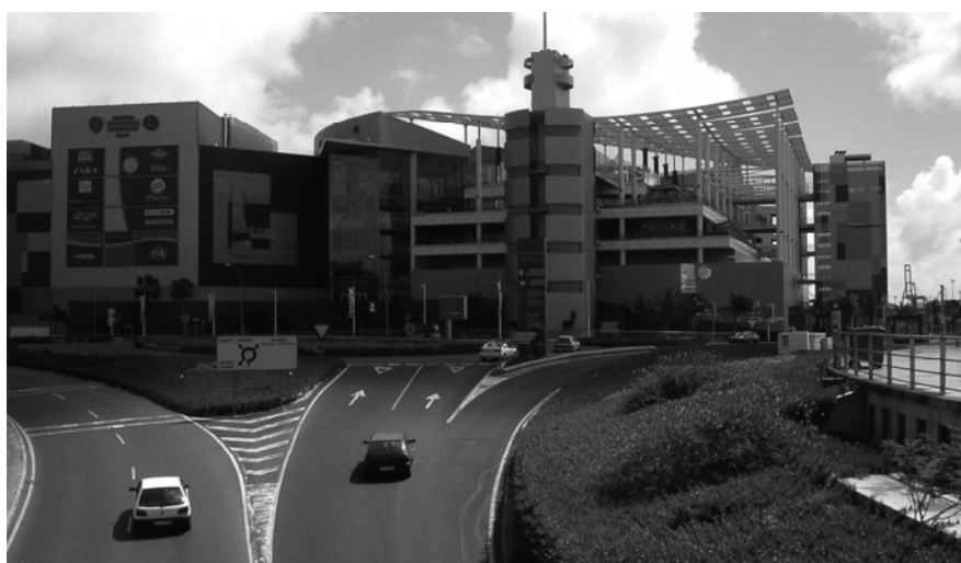
Fig. 6. Vista del gran centro comercial y de ocio “El Muelle” en el Puerto de las Palmas de Gran Canaria. Fuente: A. Grindlay, 2004.
