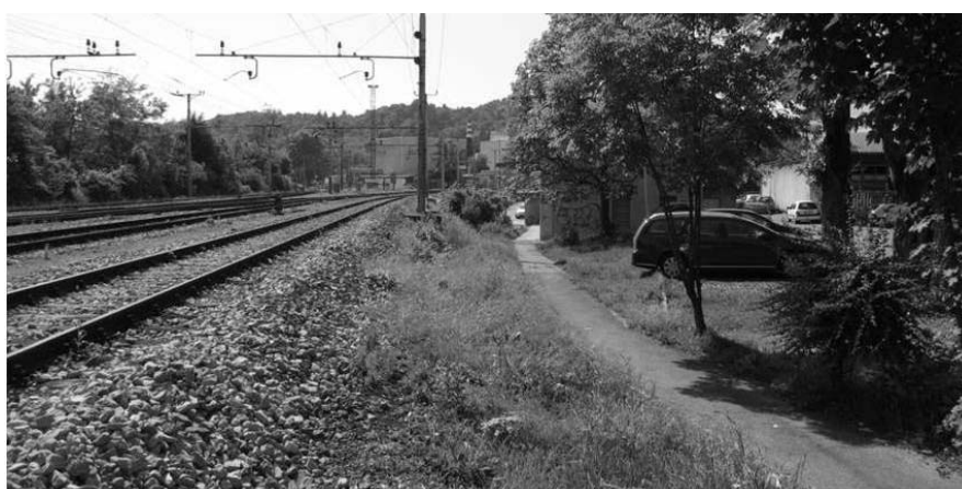
Fig. 1. Corredor ecológico ( continuum natural) a lo largo de la línea férrea (L. Fadigas).
