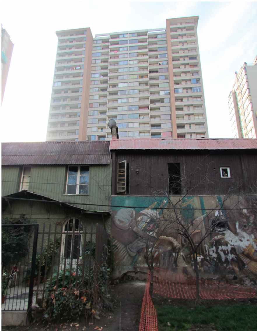
Fig. 1. Desarrollo en altura en barrio central. Ejemplo de alta constructibilidad con efecto en zonas circundantes.
