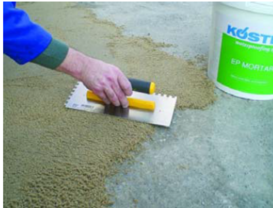
Şekil 58. KÖSTER EP Mortar epoksi esaslı tamir harcı (KÖSTER waterproofing systems).
