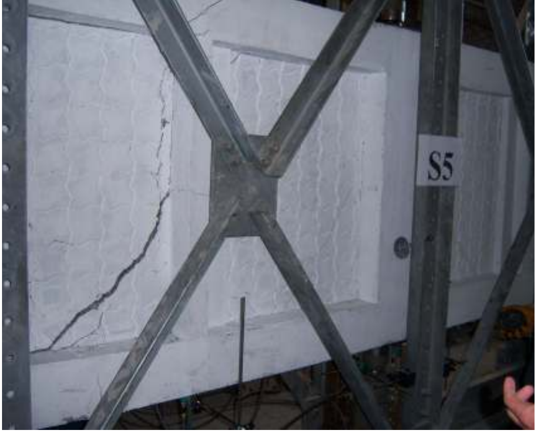
Şekil 5.48 S5 numunesi sol çerçeve Kat.2 kolon-kiriş birleşimi kesme çatlağı.
