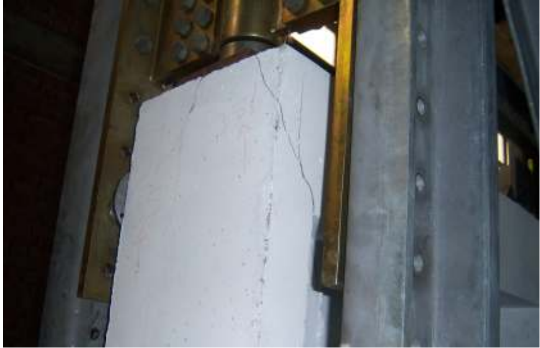
Şekil 5.47 S5 numunesi sol çerçeve Kat.2 kokon-kiriş birleşimi çatlağı.
