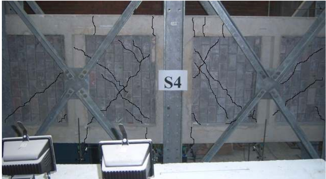
Şekil 5.38 S4 numunesi son durumu
