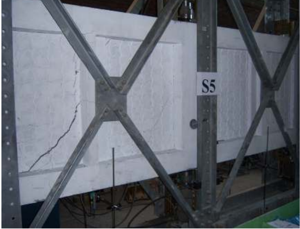
Şekil 5.46 S5 numunesi sol çerçeve Kat.2 dolgu duvar çatlağı.
