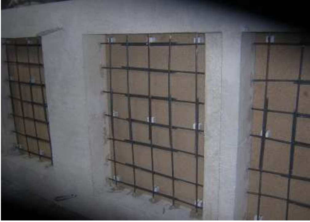
Şekil 3.9 Betonarme dolgu panelli deney numunesi için ankraj ekimi ve donatılar.
