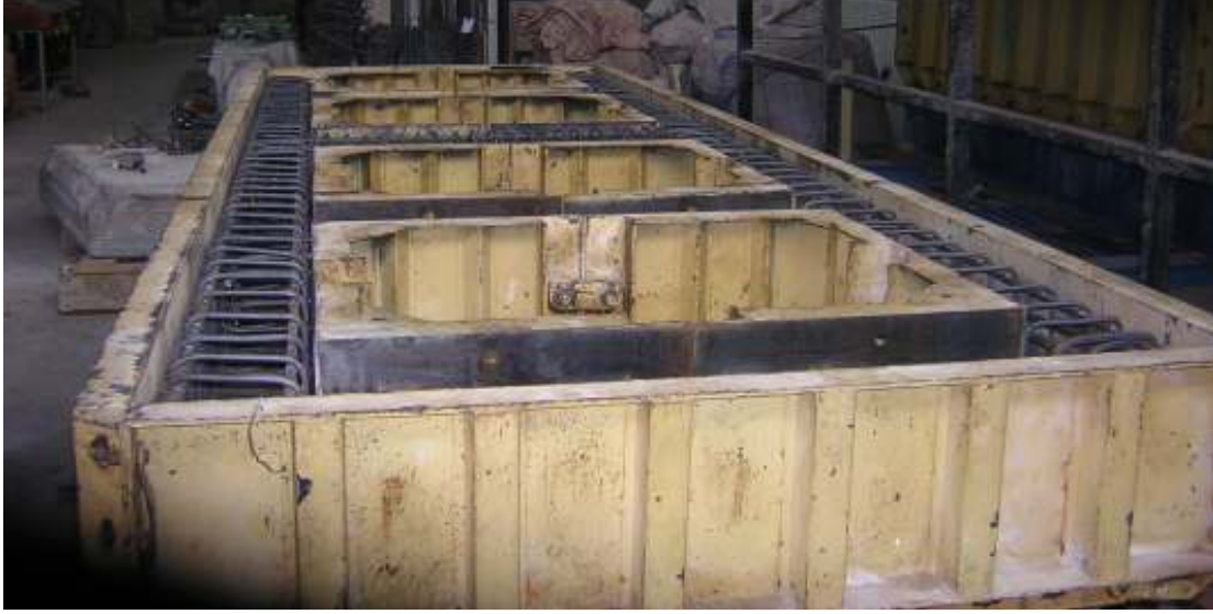
Şekil 3.2 Donatı kafesi yerleştirilmiş ve döküme hazır betonarme çerçeve kalıbı
