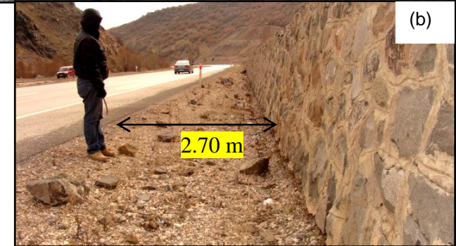
Şekil 4.17. A4 sınıfı şevin saha ve yol geometrisi ile jeolojik özelliklerini ortaya koyan görüntüler. a) Hemen hemen tüm şev yüzeyi döküntü şeklinde gelişen duraysızlık potansiyeline sahiptir. Şev yüzeyinden kaya bloklarının ayırt edici bir mekanizmaya bağlı olmadan yalnızca erozyon sonucunda döküldüğü görülmekte olup şevin eteklerinde görülen birikimler de (etek döküntüleri) döküntü şeklinde kabul edilen duraysızlıkların bir kanıtıdır. Gösterilen şev uzunluğu bu örnek için de tüm şev boyunca ölçülmüştür. (Batıya bakış). b) Duvar üzerindeki şev önü hendeğin yetersiz olmasından dolayı duvarın alt kesiminde bırakılan hendekte düşen kaya blokları görülmektedir. Ancak bu blokların pek çoğunun yola geldiği anlaşılmıştır. Yoldan başlayarak hendeğe kadar uzanan iş makinası izleri bölgede yolun kaya bloklarından temizlendiğini göstermektedir. (Güneye bakış)
