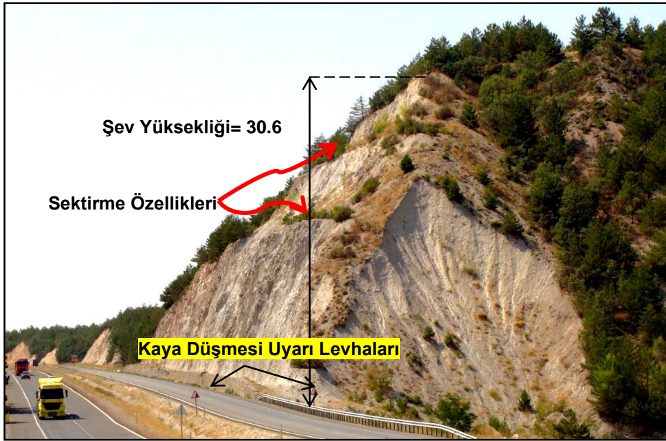
Şekil 4.8. Uyarı levhalarını ve sektirme özelliklerini gösteren bir görüntü. (Güneye bakış).
