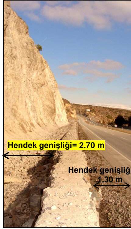
Şekil 4.9. Sınıflandırılan ilk şev olarak “A1” şeklinde adlandırılan şevin hendek tasarımının yandan görüntüsü. Hendek etkinliği için çalışma güzergahında genellikle şev önünde yer alan duvarların üzerinde ve altında bırakılan boşluk genişlikleri şeritmetre ile ölçülmüştür. Bu fotoğraf şev önündeki duvarın üzerinden çekilmiş bir görüntüdür. (Kuzeybatıya bakış).
