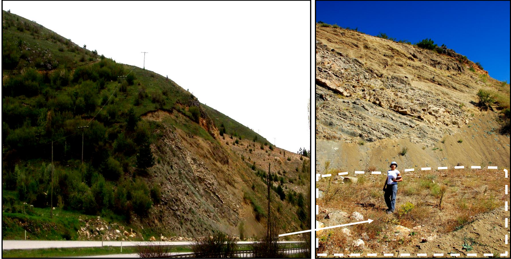
Şekil 4.3. a) Aktaş köyü yakınında “B-sınıfı” bir şev, Gerede-Bolu. b) “B-sınıfı” şevin hendeğini gösteren bir görüntü.
