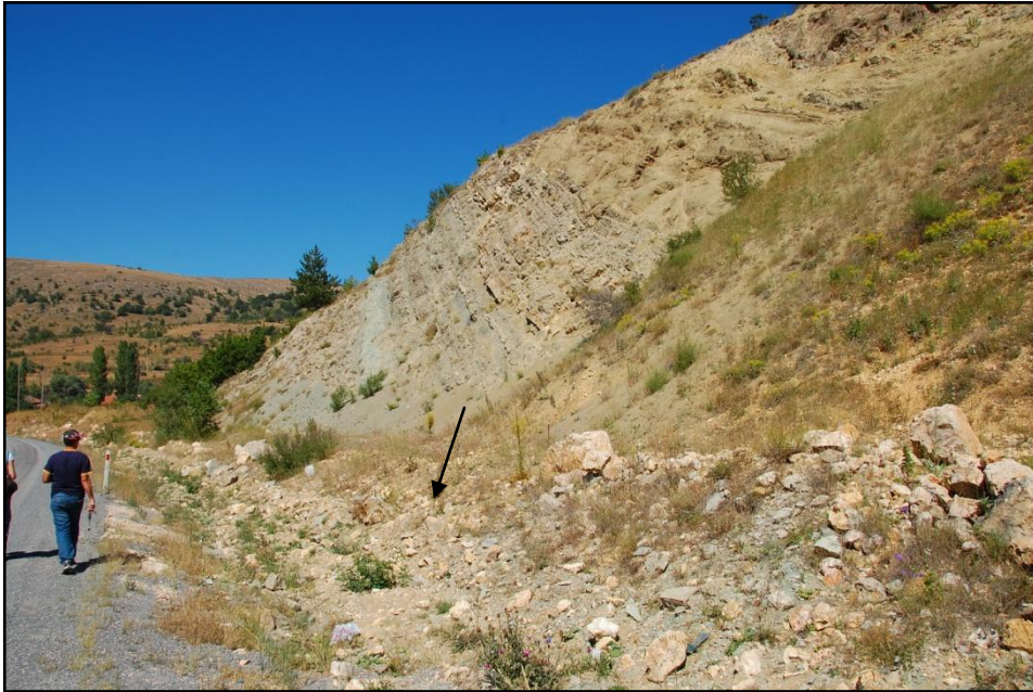
Şekil 3.2. D750 Karayolu-Aktaş Köyü yakınlarında B-sınıfı şeve bir örnek.(Kaya düşmesine karşın şevin sahip olduğu ve düşen kayaları tutabilecek kapasitedeki geniş hendek yapısına dikkat çekilmektedir).
