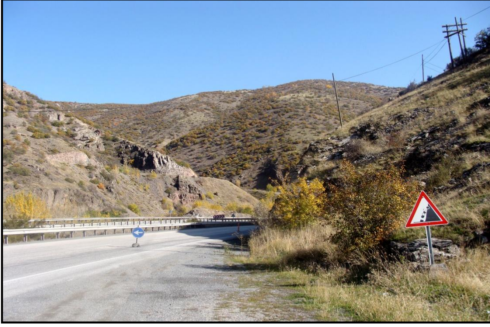
Şekil 4.5a. Bölgenin kaya düşmesine duyarlı olduğunu gösteren uyarı levhası.
