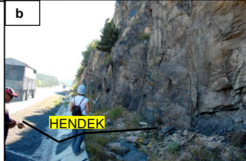
Şekil 4.33. A17 sınıfı şevin özelliklerini gösteren şekiller. a) Kama kayması ve döküntüye bağlı gelişen yenilmeler gösteren şev (Kuzeye bakış). Şekil şevin yalnızca bir parçasını göstermekte olup D3 ile gösterilen kısım oldukça geniş alan kaplamaktadır. b) Şev önü hendek orta derecede kaya tutma kapasitesine sahiptir.
