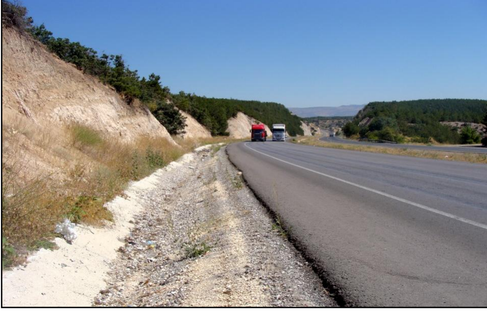
Şekil 3.3. Kurtboğazı Barajı'na bakan yüksekliği az ve kaya tutma kapasitesi yüksek hendek ve banketli "C-sınıfı" şeve bir örnek.
