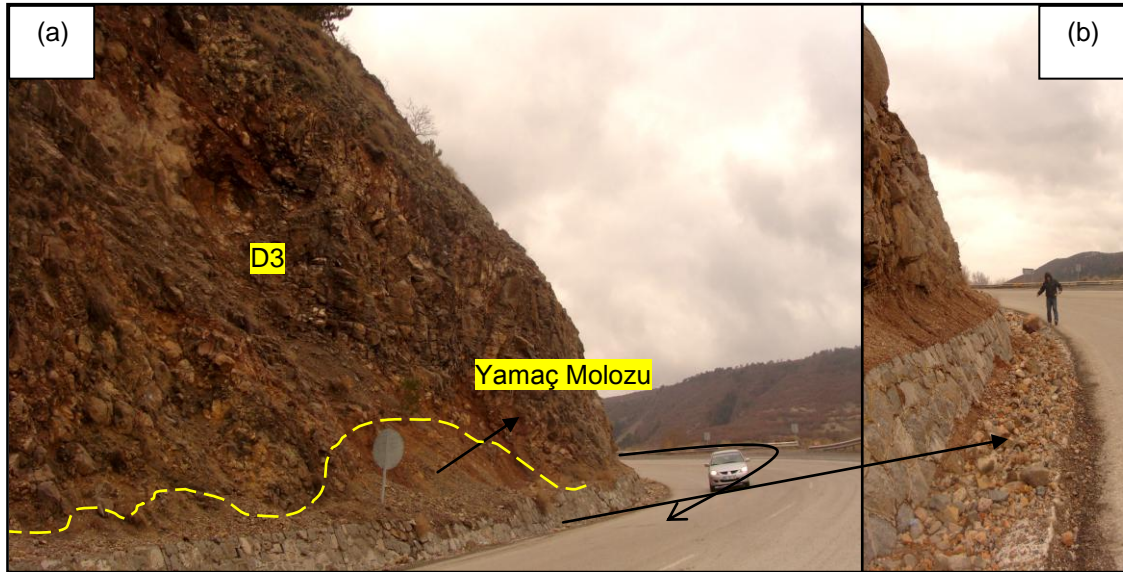
Şekil 4.20. Virajlı bir yolun gerisindeki görüntüleri gösteren şekiller (Güneybatıya bakış). a) Okla gösterildiği gibi yolda var olan viraj DSD'nin sürücüler açısından neden çok sınırlı olduğuna dikkat çekmektedir. Kesik çizgiler altında görülen şevin eteklerindeki döküntüler bu şevdeki hakim yenilme mekanizmasının bir kanıtıdır. b) Şevden dökülen kaya parçalarının hendekdeki görüntüsü.
