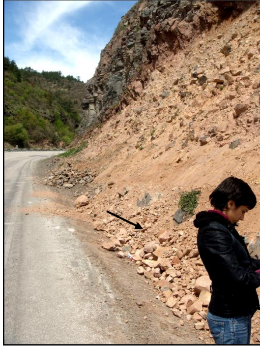
Şekil 3.1. D750 Karayolu-Azaphane Geçidi boyunca yer alan “A-sınıfı” şevlerden bir örnek. (Dar hendek yapısına ve kayaların yola gelmeye eğilimli olduğuna dikkat çekilmektedir).
