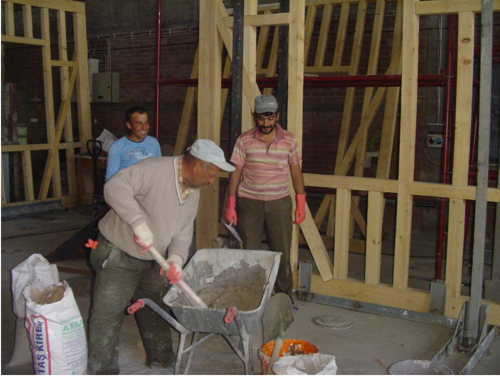
Şekil 262: Geleneksel kireç harcının karılması
