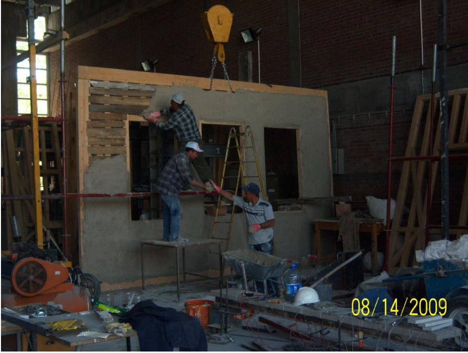
Şekil 243: Çerçeveye çakılan ahşap elemanların daha sonra üstleri sıvandı.
