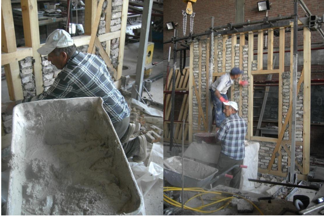
Şekil 203: Dolgunun örülmesi işlemi
