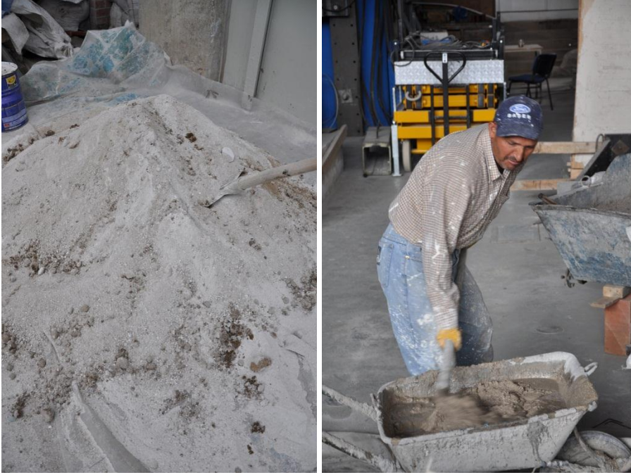
Şekil 284: Sivanın hazırlanması
