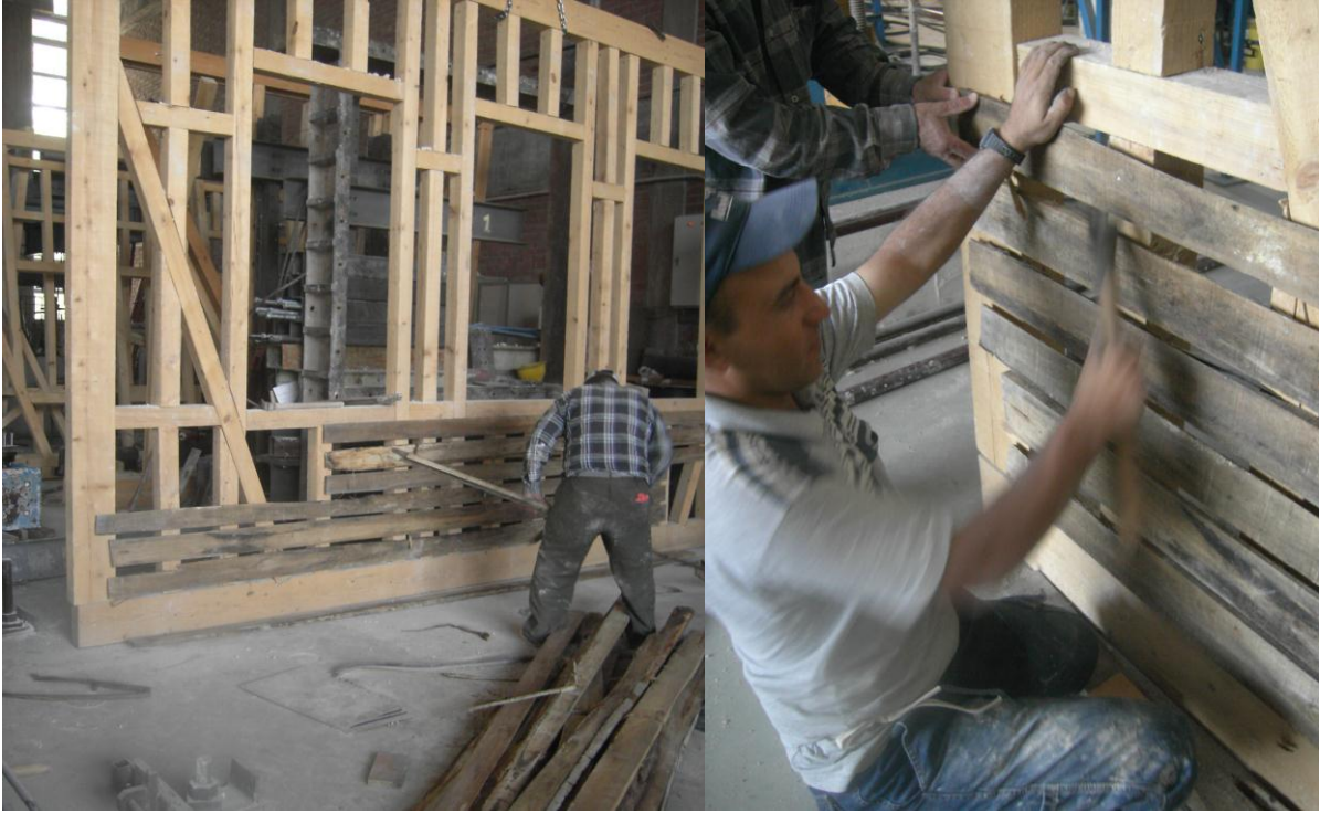
Şekil 242: Önce ahşap elemanlar, çerçeveye denk geldikleri her noktada 1 adet çiviyle çerçeveye sabitlenecek şekilde çakıldılar.
