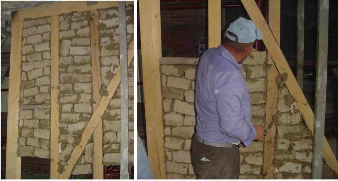
Şekil 165: Kerpiç dolgunun hazırlanması
