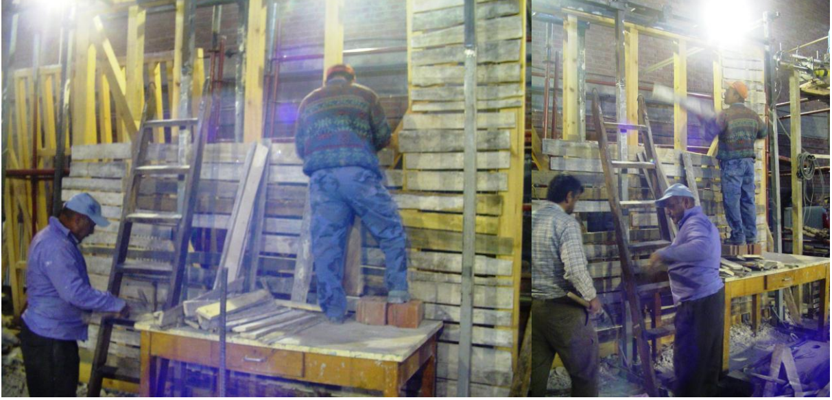
Şekil 183: Şam dolma örgü için ahşap elemanların çakılması
