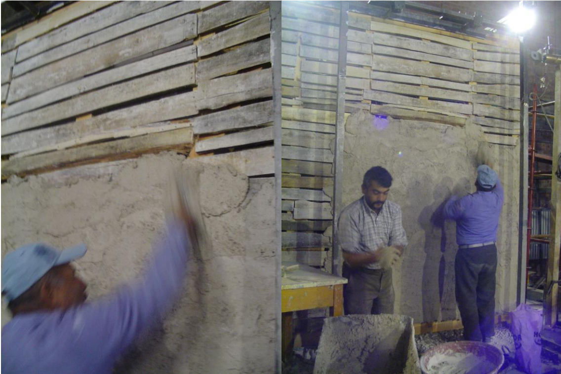
Şekil 184: Şam dolma dolgunun üzerine siva uygulanması
