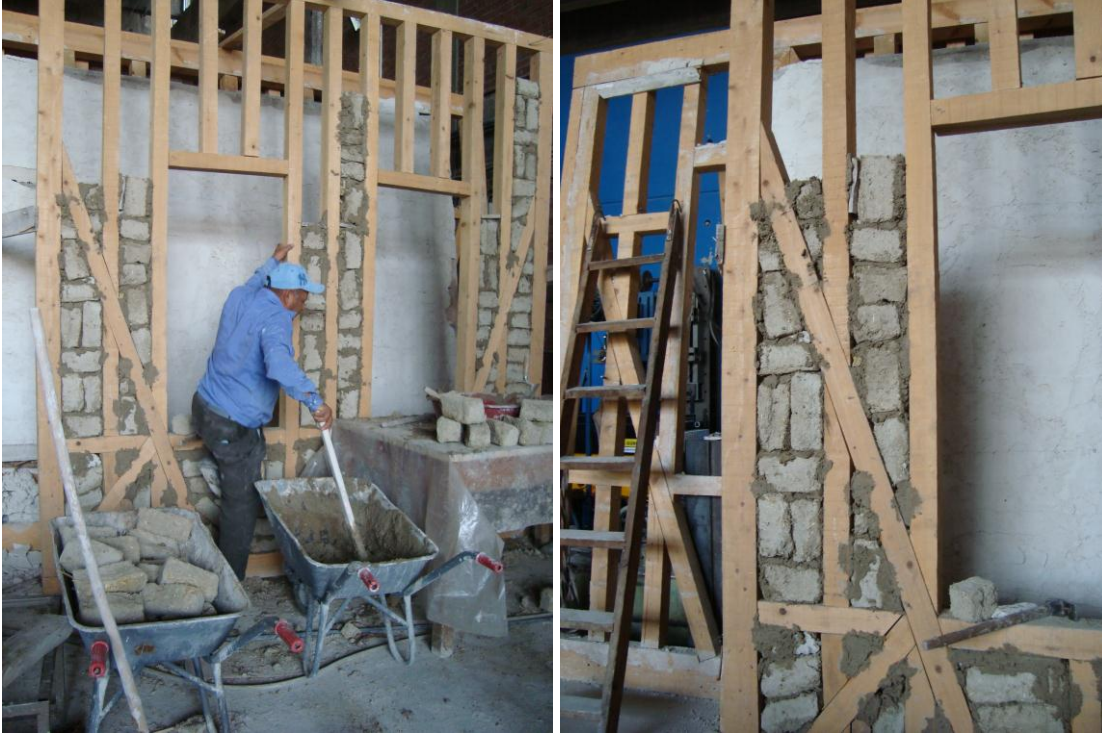
Şekil 145: Kerpiç dolgunun örülmesi
