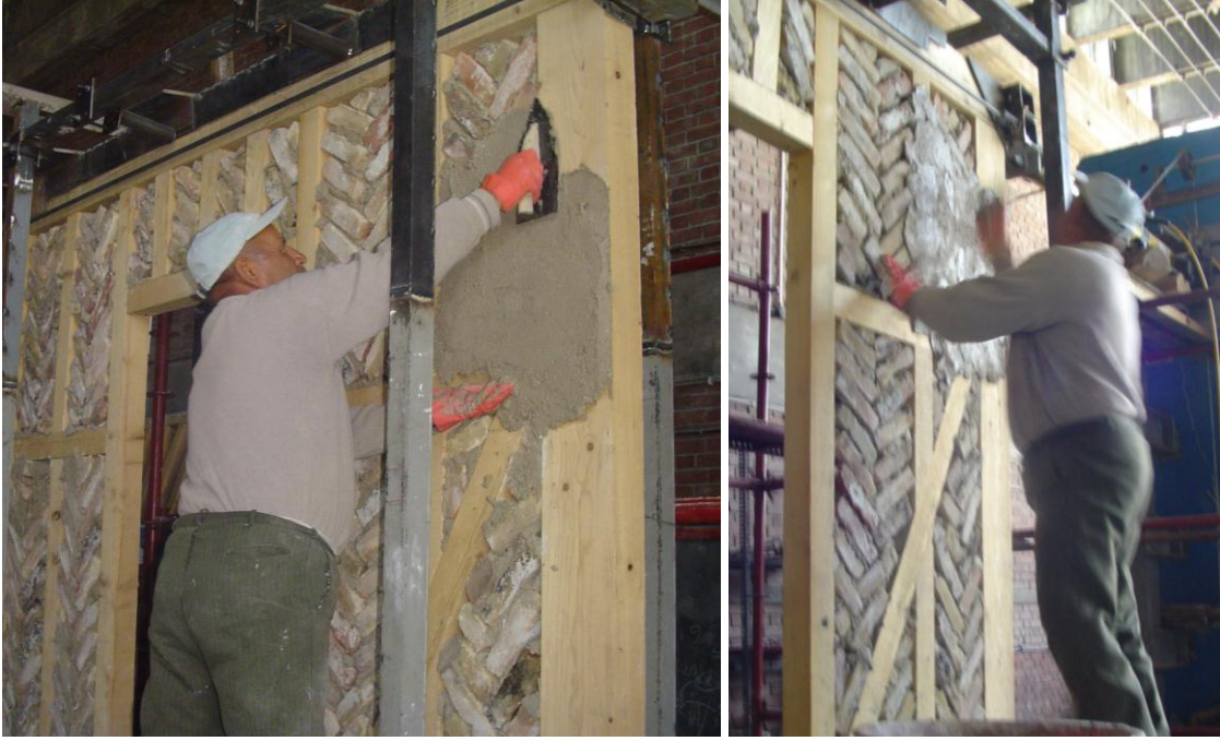
Şekil 266: Çerçevenin sıva aşaması görünümüleri
