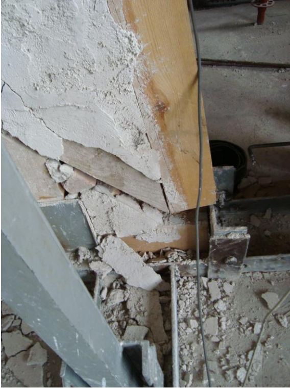
Şekil 222: Bağlantılarda gerçekleşen açılmalar
