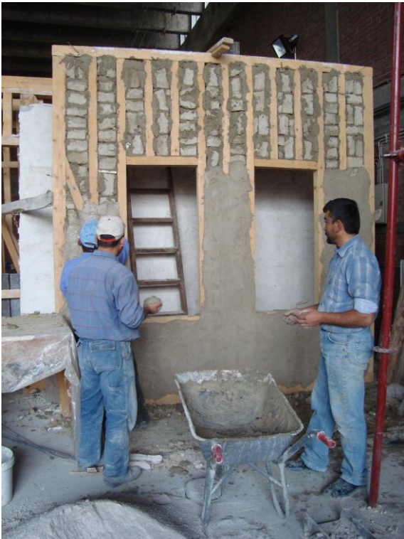
Şekil 146: Dolgunun tamamlanmasının ardından çerçevenin üstünün sıvanması
