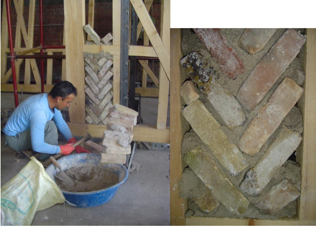
Şekil 264: Yedinci çerçeve açıklıklarının tuğla ile doldurulması çalışmaları
