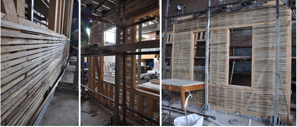
Şekil 283: Bağdadi kaplamanın uygulanması
