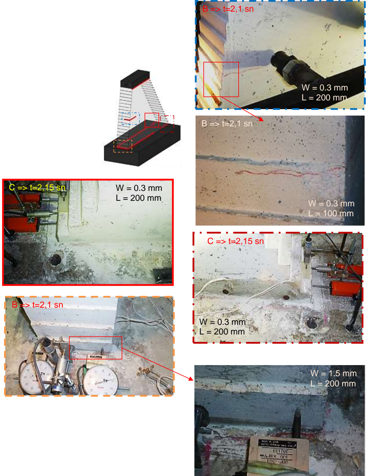
Şekil 74. MCE Depremi Esnasında Oluşan Çatlaklar 2
