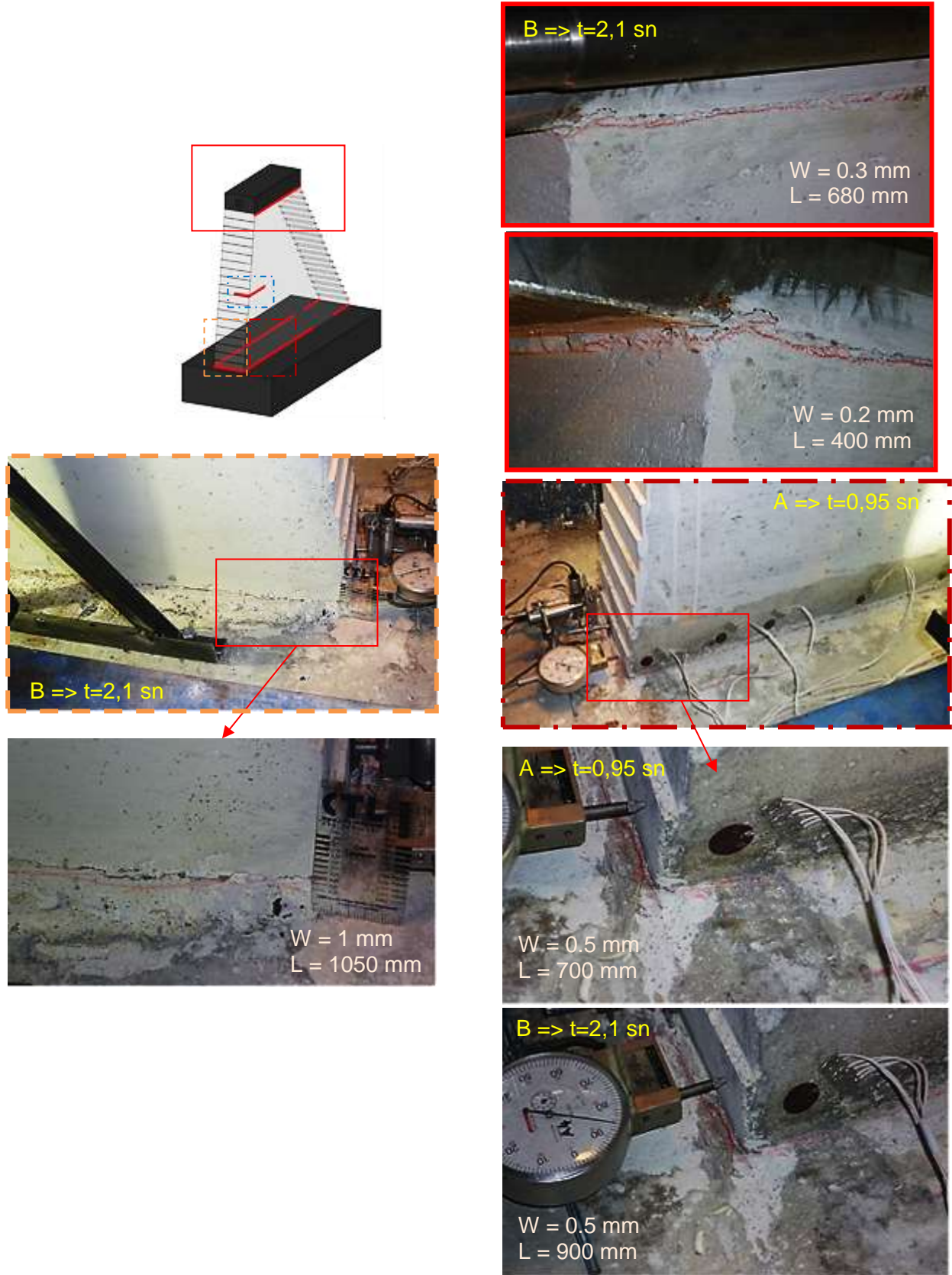
Şekil 73. MCE Depremi Esnasında Oluşan Çatlaklar 1
