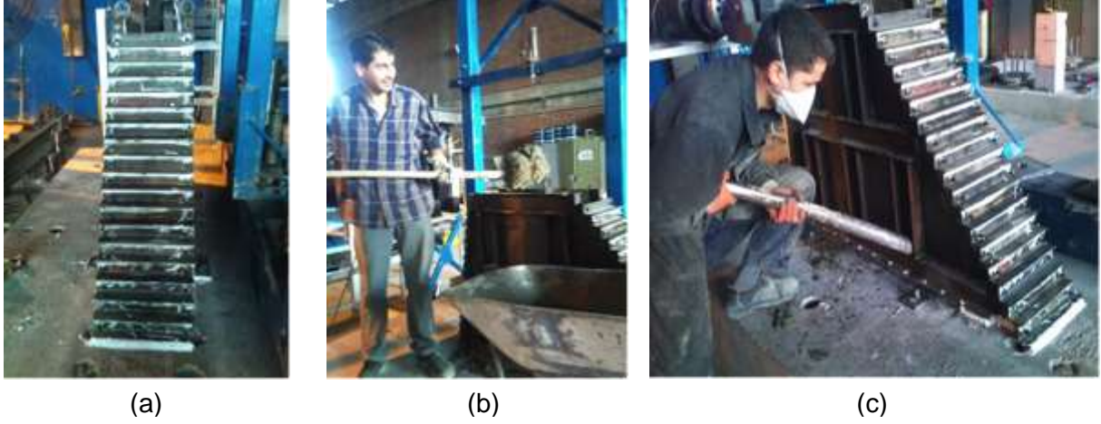
Şekil 47. Beton Dökümü : (a) Kalıbın Silikonlanmış Hali; (b) Betonun Kalıba Yerleştirilmesi ve (c) Kalıp Dışından Yapılan Vibrasyon
