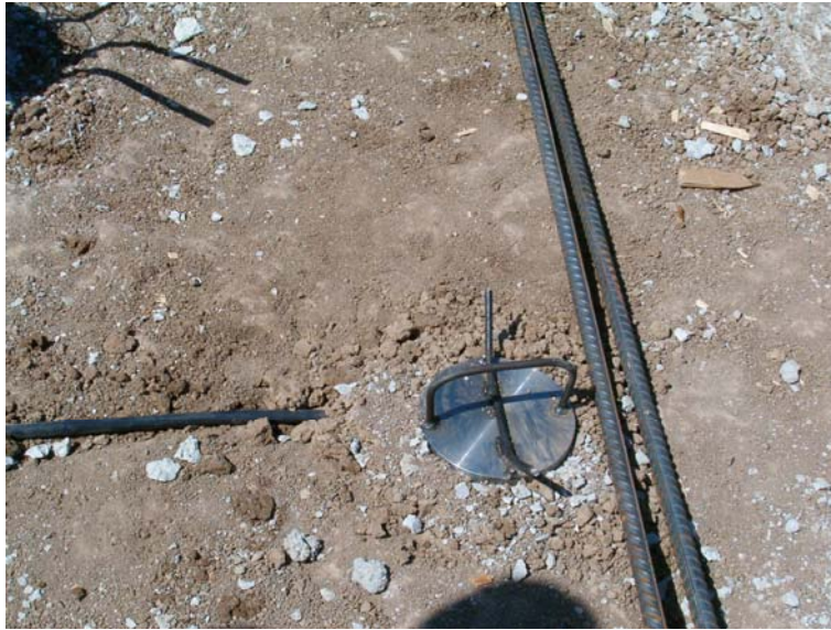
Şekil 2.8 Zemin basınç ölçerin radye altına yerleştirilmesi
