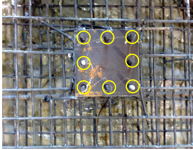
Şekil 3.4 Temele kaynaklanan bulonların genel görünüşü
