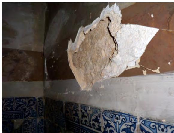
Fig. 14 – Desagregação e falta de aderência do revestimento
