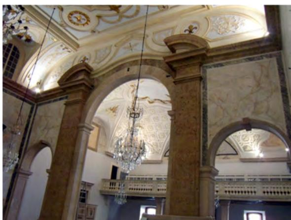
Fig. 5 – Parede da Capela-mor, lado sudoeste, onde se observa os três tipos diferentes de pintura de fingidos.
