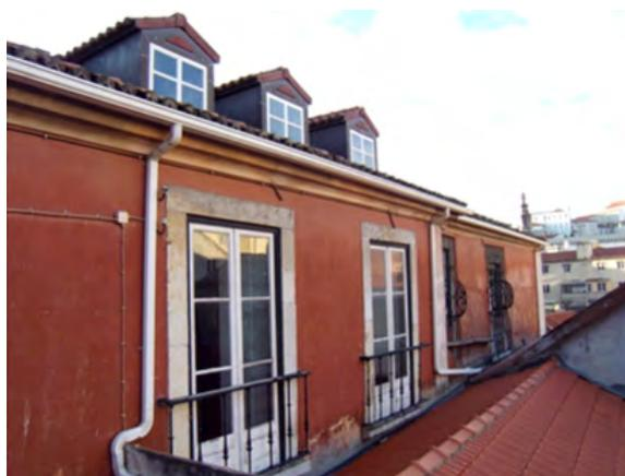
Fig. 10 – Deficientes sistemas de drenagem, caleiras, algerozes e tubos de queda, fachada noroeste
