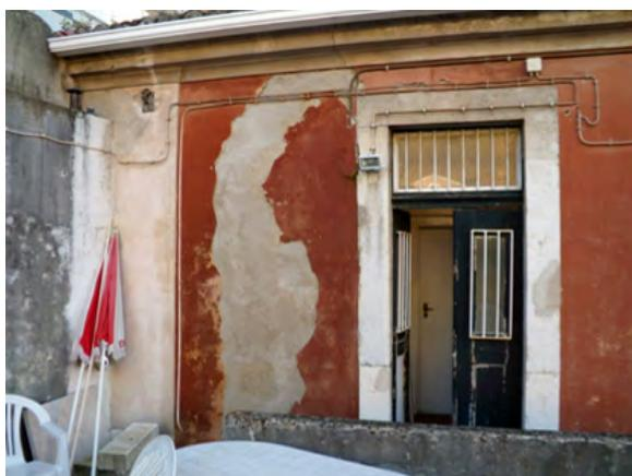
Fig. 9 – Degradação do revestimento exterior, fachada noroeste (Piso 3, a 12,2m em relação pav. Capela-mor)
