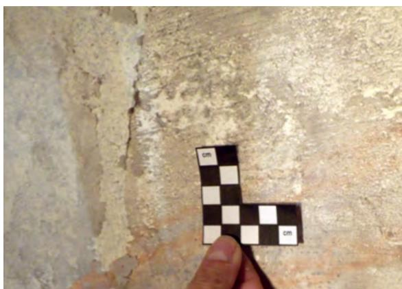
Fig. 11 - Manchas do escoamento de água por infiltração.
