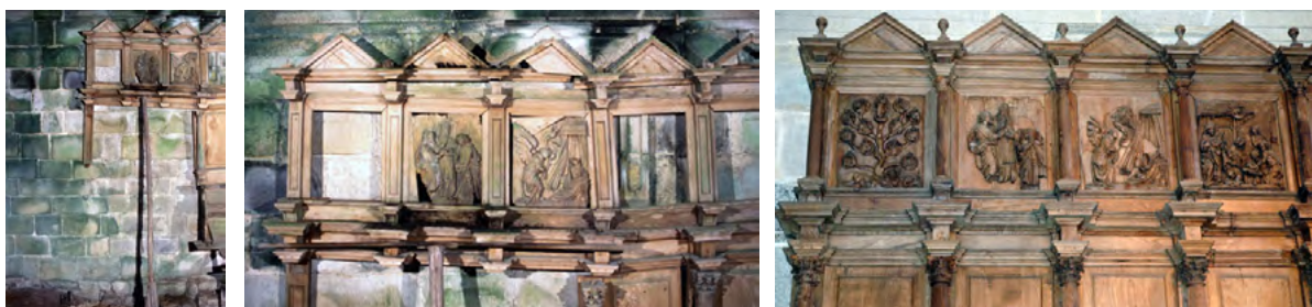
Fig. 7, 8 y 9 - Santa María de Montederramo, Ourense. Sillería de coro, detalles antes y después de la restauración
