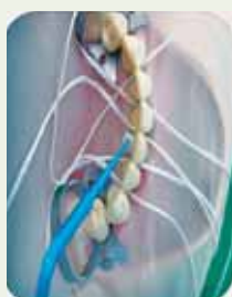
Fig. 7 - Aplicação do adesivo e impregnação da fibra
