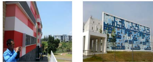
Gambar 3 Permainan Warna pada Gedung TK dan Gedung sekolah SMP dan SMA
