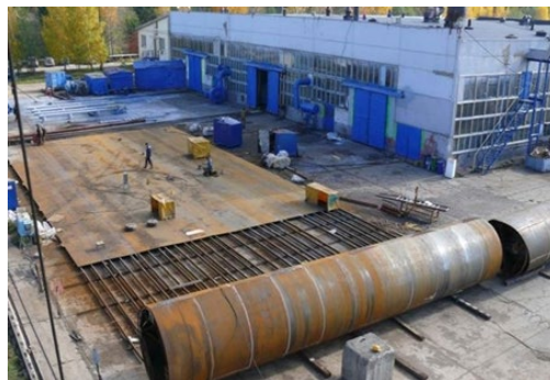
Сборка и сварка полотнища стенки на открытой заводской площадке
