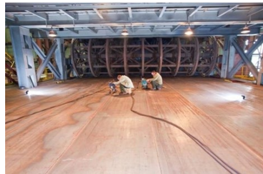
Сборка и сварка полотнища стенки в цеховых условиях
