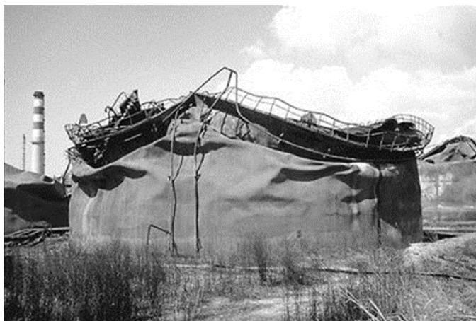
Рисунок 1.10 – Разрушение резервуара с последующим разливом нефти в Мраморное море
