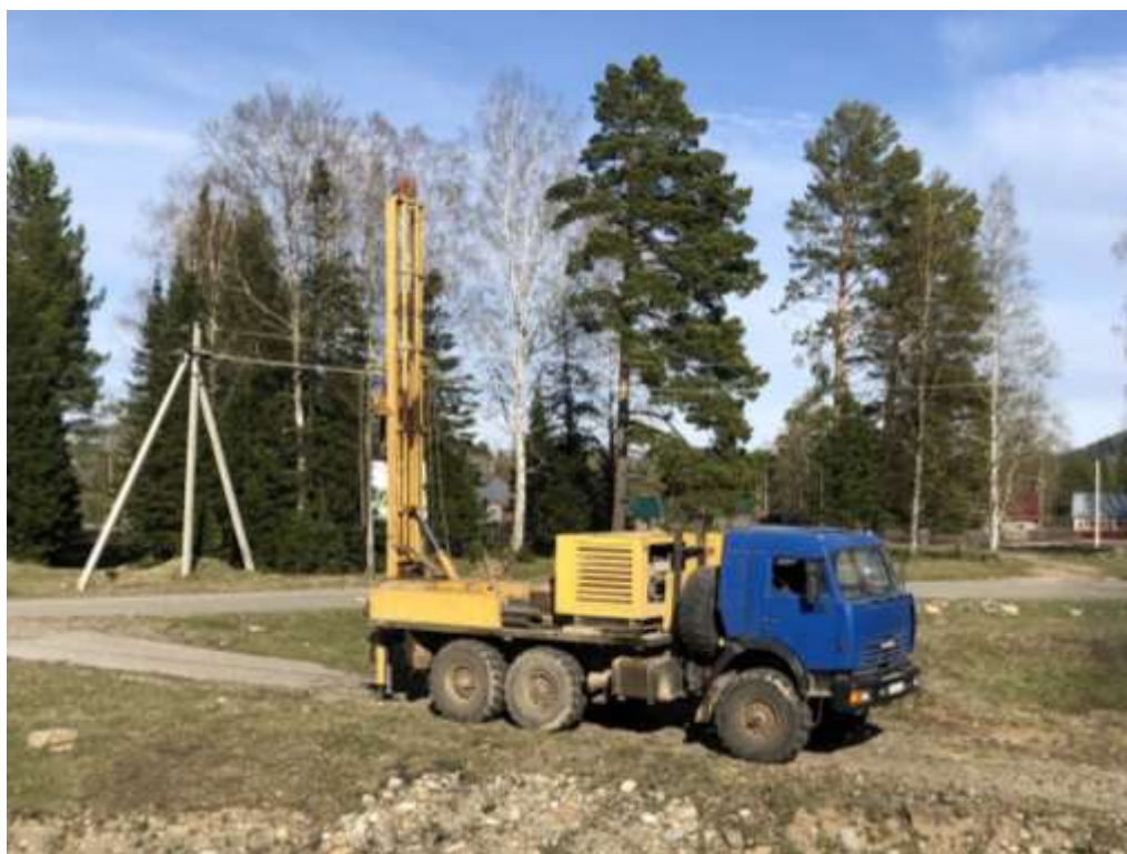
Фото 5 - Буровая установка УРБ-2А2
