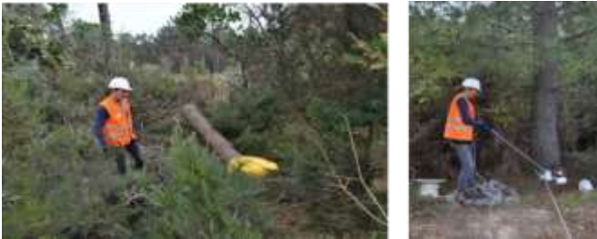
Şekil 2. Bölme içerisinde el vincinin kullanımı
