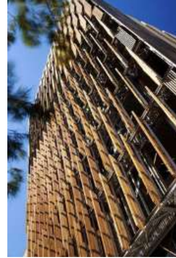
Şekil 3. CH2 Binası Melbourne, Avustralya (URL-4 2019)
