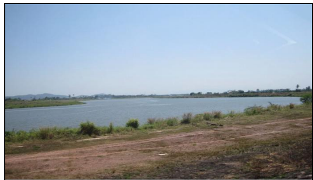
Fig. 3 - Sungai Muda levee system
