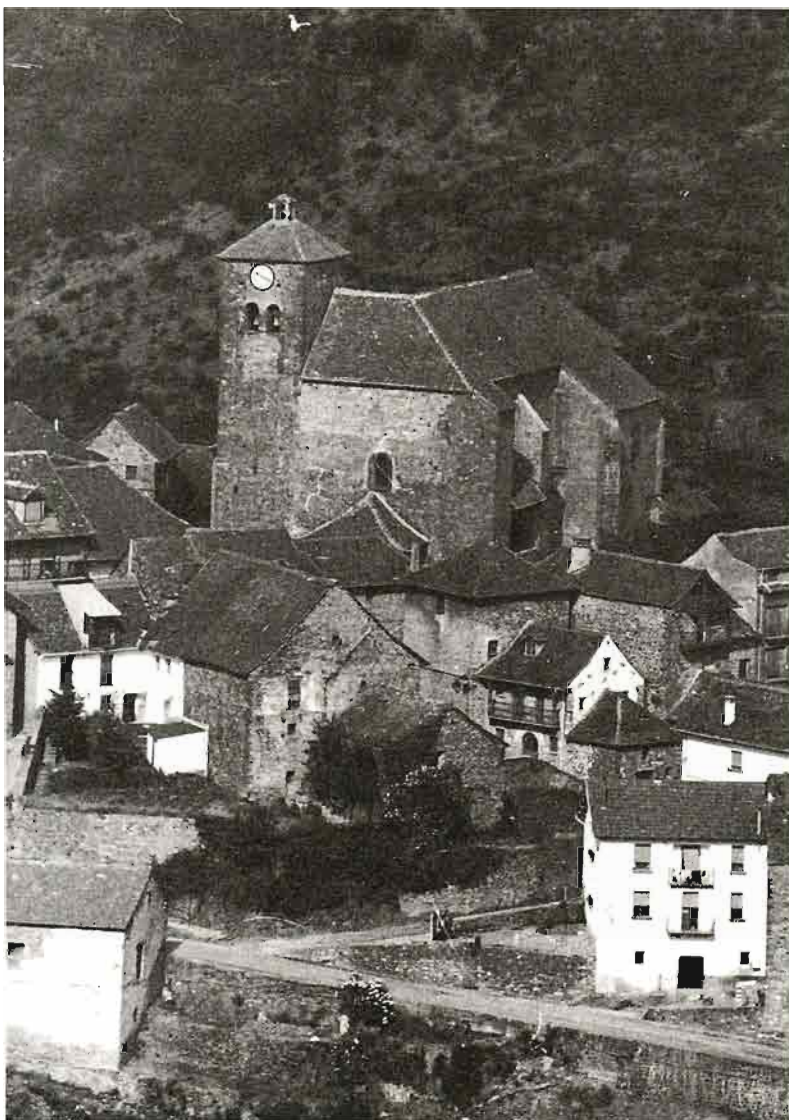
Foto 12: Iglesia de San Pedro, después de restaurados el tejado y la fachada occidental.
