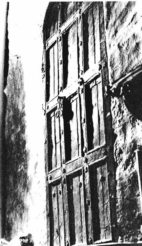
Foto 15: Puerta de hierro, acceso desde el coro a la cámara abovedada del ángulo SW.
