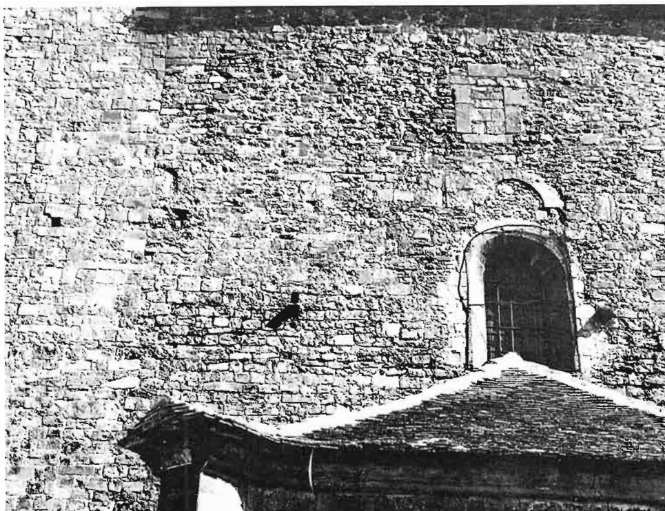
Foto 4: Fachada W y torre después de la restauración.
