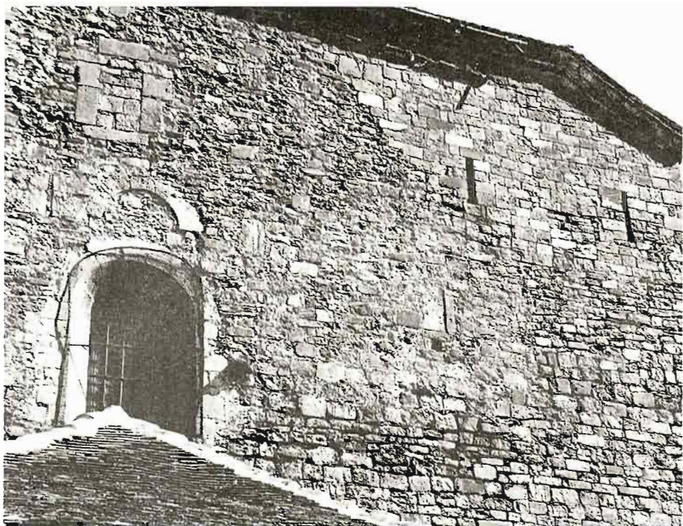
Foto 5: Fachada W después de la restauración.
