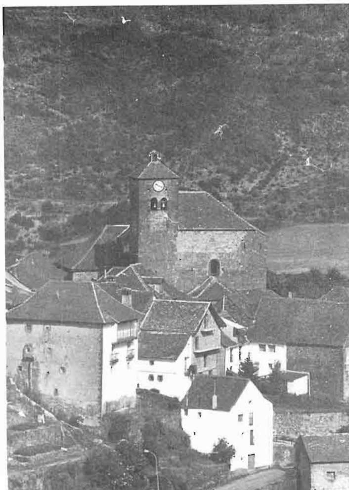
Foto 8: Iglesia de San Pedro, fachada occidental tras las restauraciones. A izquierda, el tejado de la sacristía nueva.
