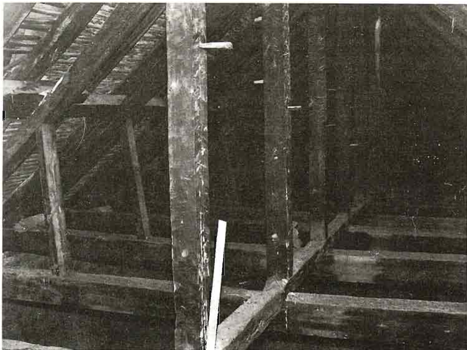
Foto 23: Techumbre de la nave. Las vigas horizontales que unen el muro norte al muro sur de la nave están a 120 cm de la clave de las bóvedas.
