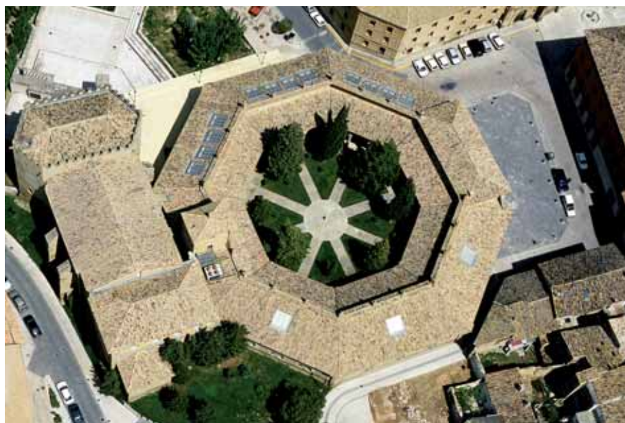
Edificio octogonal, construido a partir de 1690 como sede de la Universidad de Huesca; junto a él, el teatro o paraninfo universitario, de los años treinta del siglo XVII (actual Museo de Huesca).
