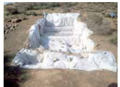
Figura 17. Protección de los sondeos con malla geotextil.
