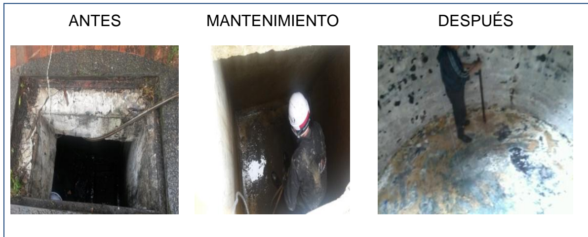
Imagen 4. Mantenimiento de tanques de agua lluvia
