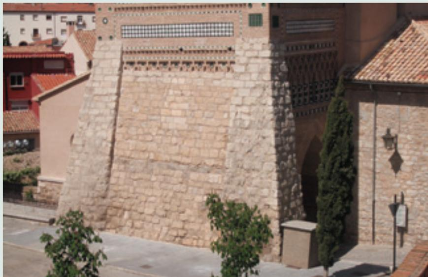
Talud de sillería colocado por Pierres Vedel en la base de la torre de San Martín.
