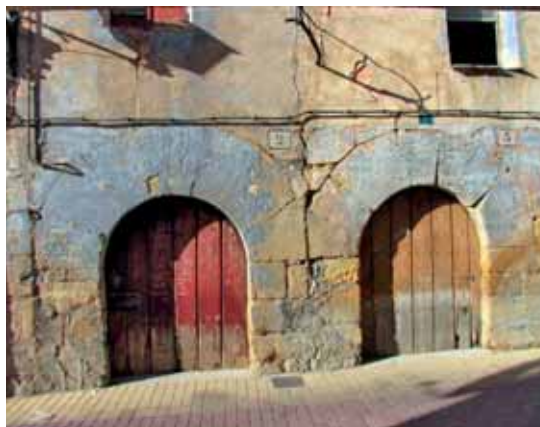
Puertas de la calle del Muro de Caspe
