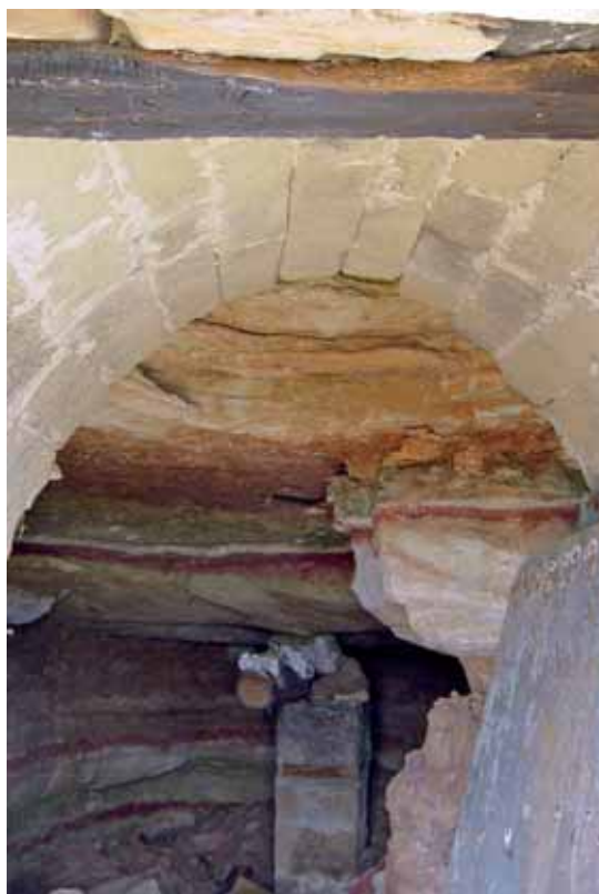
Segunda bodega, conectada a la principal, tras un paso tapiado en el muro norte
