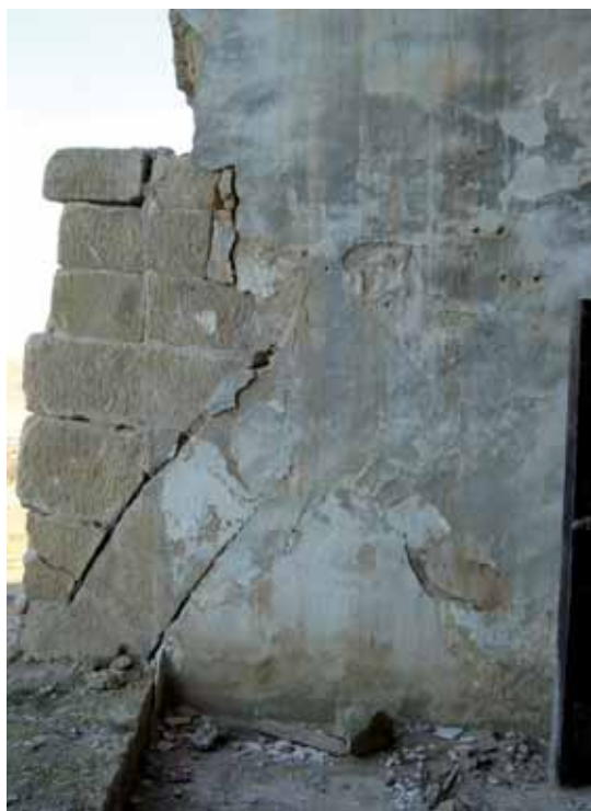
Aparición de arcos góticos en los muros transversales
