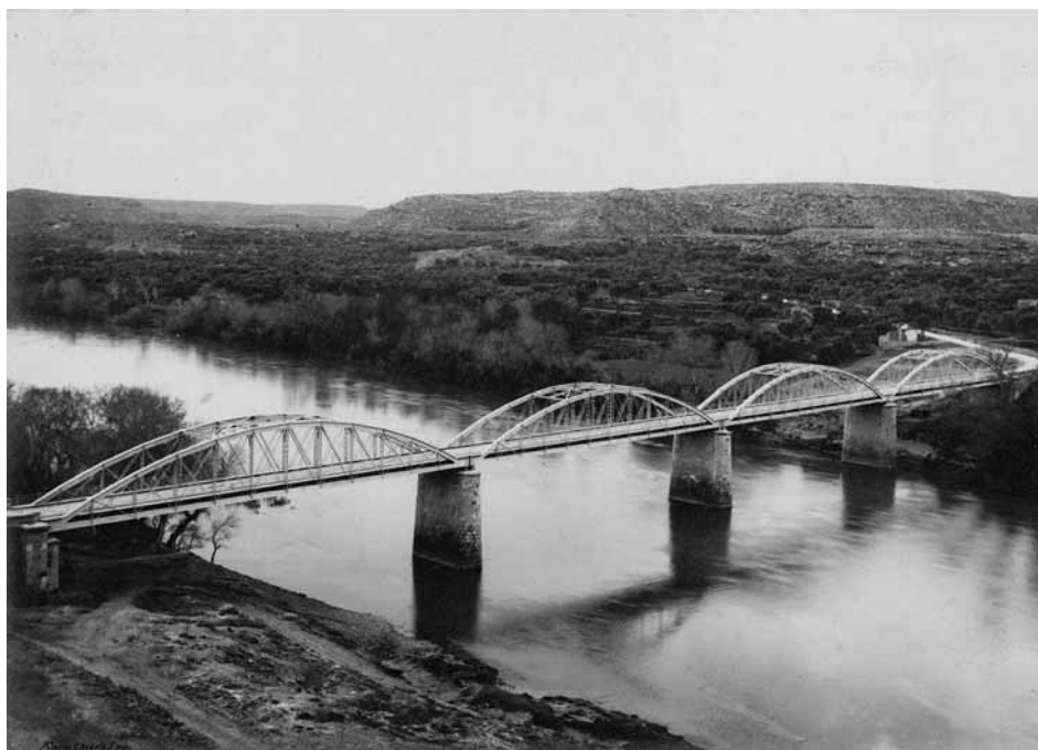
Puente sobre el Ebro en Caspe (hacia 1930)
