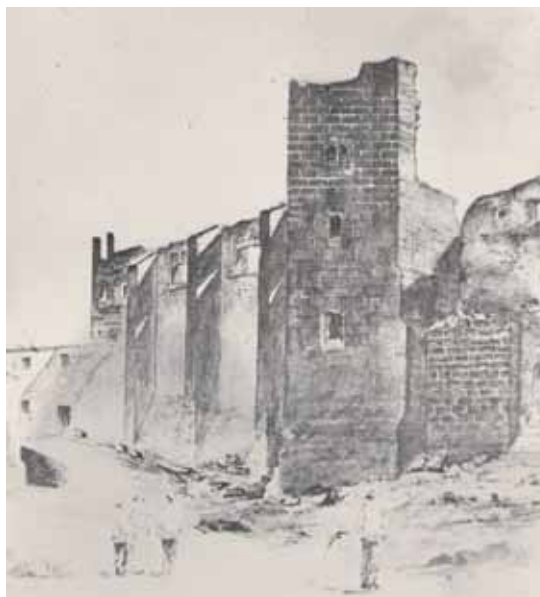
Vista del lado oeste del castillo a finales del siglo XIX
