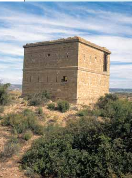
Torre óptica de Turlán en Caspe
