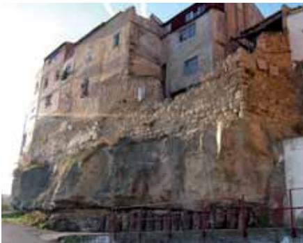
Figura 19. Viviendas cimentadas sobre un paleocanal en la Ronda del Bailío (Caspe)
