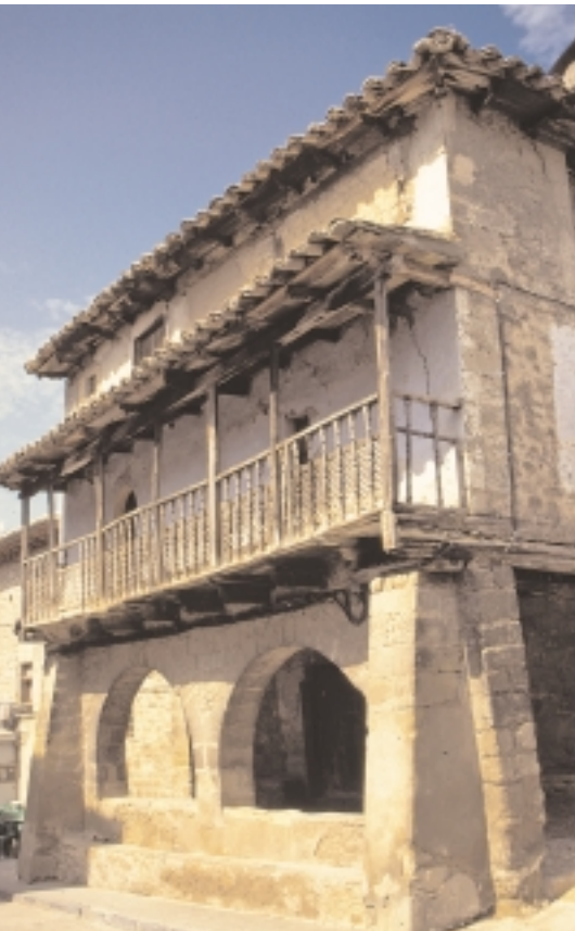
Casa con porche y galería de madera en Biel
