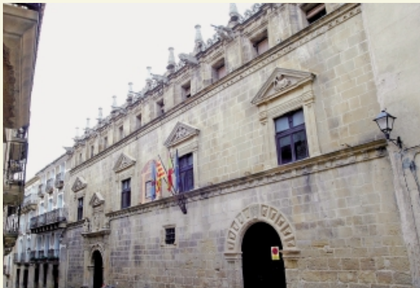
Fachada principal de la Casa de la Villa de Uncastillo (siglo XVI)
