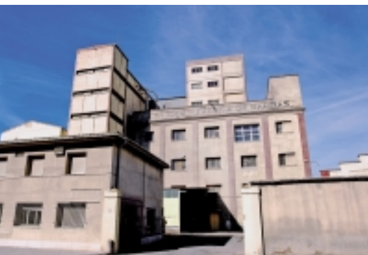
Tauste. Antigua fábrica de harinas La Victoria
