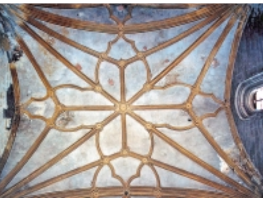
Bóveda de la iglesia parroquial de San Martín de Biel
