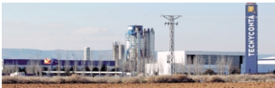
Empresa de prefabricados en Tauste
