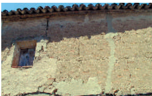
Pared de tapial reforzado con ladrillo en Salas Altas
