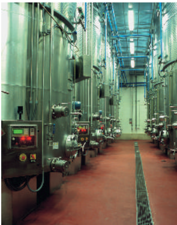
Interior de una bodega
