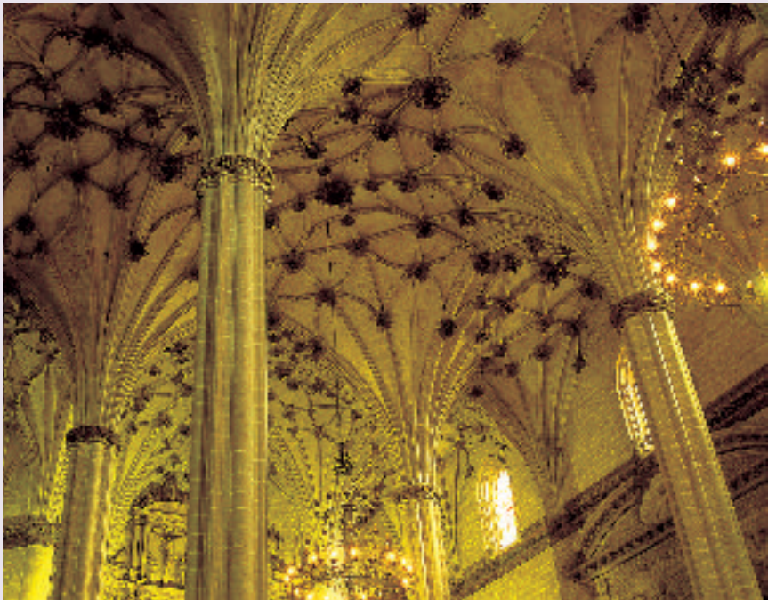
Bóvedas de la catedral de Barbastro
