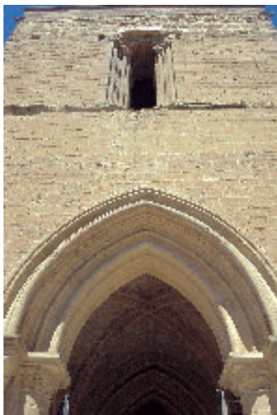
Berbegal. Torre campanario
