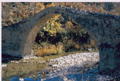
Puente de la Albarda, sobre el Vero
