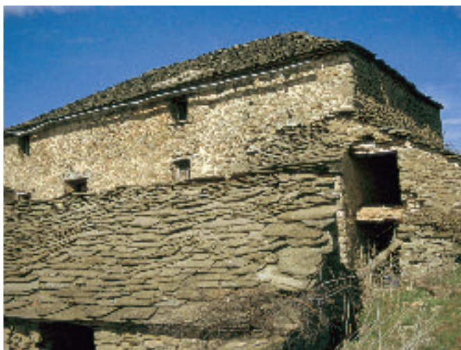
Pardina de Villanúa (valle de Rodellar). Cubiertas de losa
