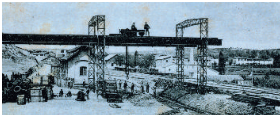
Catalana de Gas y Electricidad. Nº 282. Grúa de descarga de materiales en la estación de Barbastro. (6-V-1916)
