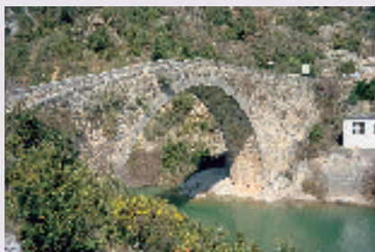
Puente de Pedruel, sobre el Alcanadre
