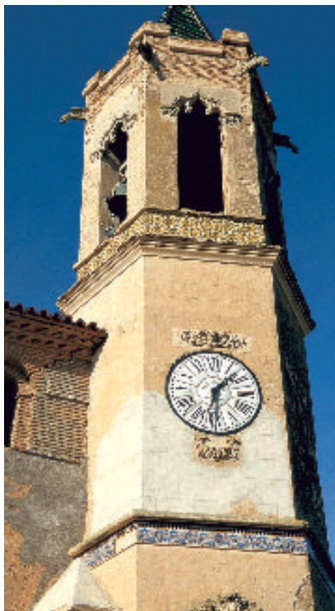
Torre de la iglesia de Laperdiguera
