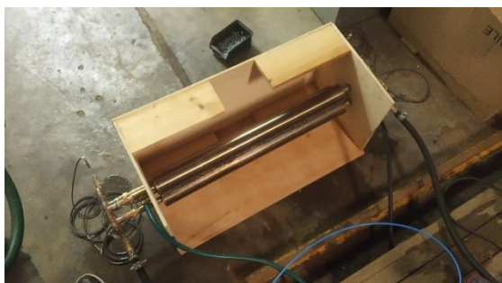
Obr. 26 Svazek potrubí nachystán pro zaizolování
