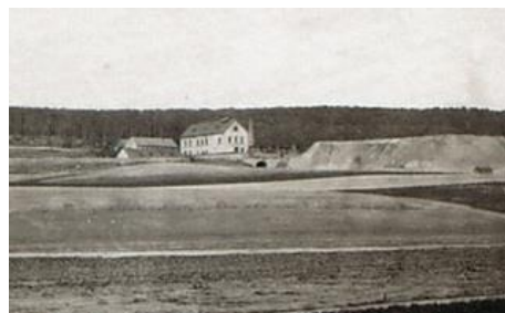
Obr. 188 Jáma Ludvík ve Vrapicích. Jámu započal hloubit v roce 1813 Jan Černý, v roce 1882 ukončena těžba PŽS. zdroj: hornictvi.kladnominule.cz
