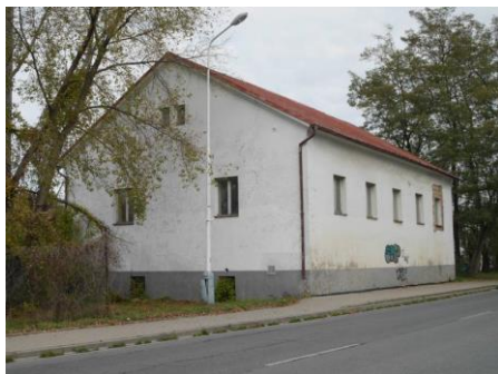
Obr. 127 Nákladová stanice Staré Kladno stávající stav zdroj: NPÚ Památkový Katalog
