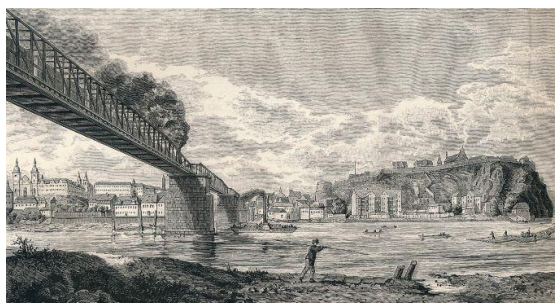
Obr. 157 Železniční nýtovaný most z roku 1872 autor kresby: František Chalupa Ottovy Čechy 1892 Pohled ze smíchovského nábřeží k Vyšehradu.
