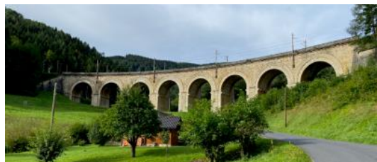
Obr. 123 Rumpelgraben viadukt foto z roku 2018 zdroj: rad-forum.de
