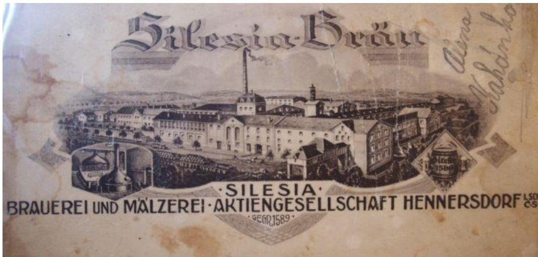
Obr. 294 Průmyslový pivovar v Jindřichově po modernizaci a přestavbě v roce 1926 zdroj: pivovary.info
