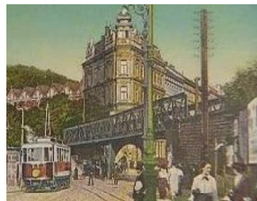
Obr. 156 Most Malá Hrabovka nýtovaná konstrukce opřena jednou nohou do ulice Husitská odolávala i zatížení moderních vlaků ve 20. století. Konstrukce byla snesena v roce 1992 a nahrazena novou. zdroj: Časopis o Praze 3 ze dne 12.5.2009
