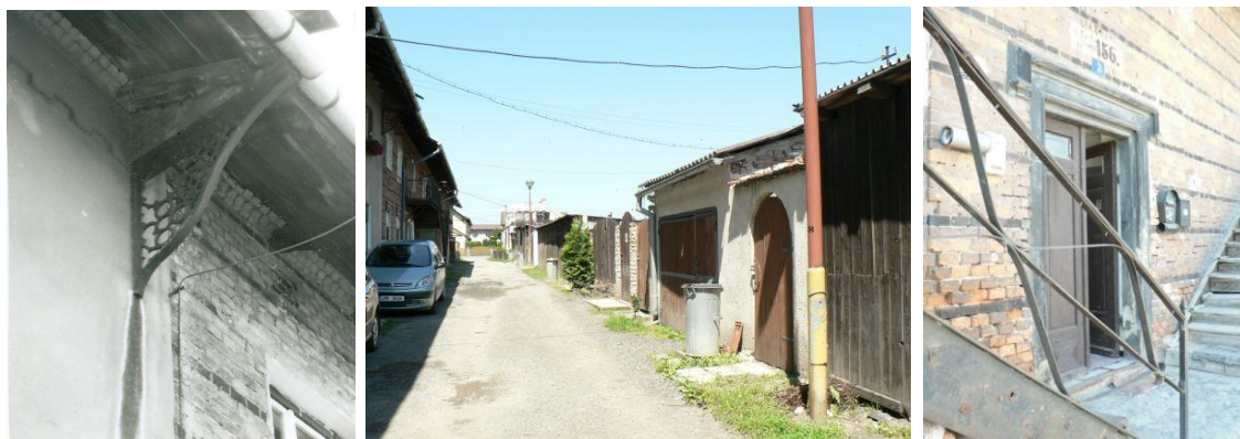
Obr. 245 Vlevo: detail litinové konzoly foto 80. léta 20. století zdroj: archiv VM v Šumperku Uprostřed: Pohled na uspořádání obytného a hospodářského objektu zdroj: vlastní fotoarchiv Vpravo: Detail původní železné konstrukce zábradlí venkovního schodiště a pohled na kamenné profilované ostění kolem hlavního vstupu do objektu rok 2012 zdroj: vlastní fotoarchiv
