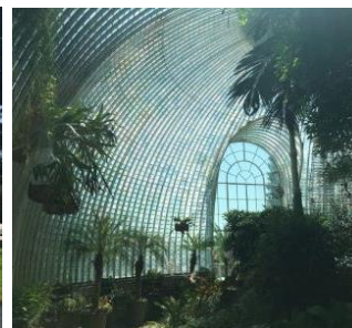
Obr. 61 Původní litinová konstrukce zámeckého skleníku v Lednici rok 2016, vyrobená v Sobotínských železárnách roku 1844 celkové pohledy a vnitřní prostor zdroj: vlastní fotoarchiv
