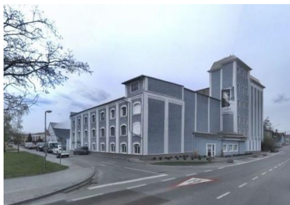
Obr. 286 Stávající stav z roku 2017 zdroj: vodnimlyny.cz Přestavba na počátku 20. století se dochovala bezzměn
