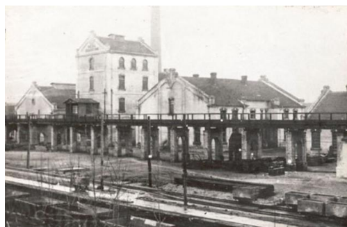
Obr. 177 Důl číslo III v Nučicích z roku 1897 stavba transportní rampy zdroj: Solvayovy lomy
