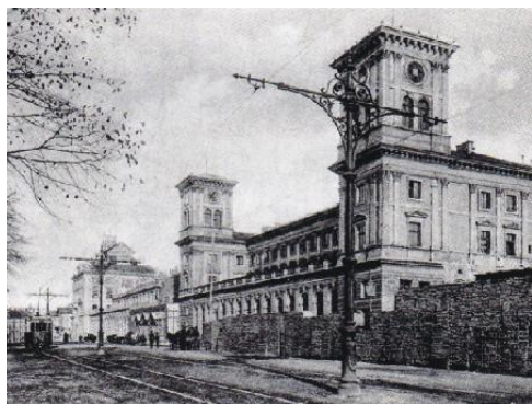
Obr. 153 Historická budova Nádraží Františka Josefa z roku 1871 Zdroj: vagony.cz Původní neorenesanční budova s dvojicí věží dle návrhu architekta Antonína Barvitiuse sloužila svému účelu 30let, kdy přestala kapacitně stačit.
