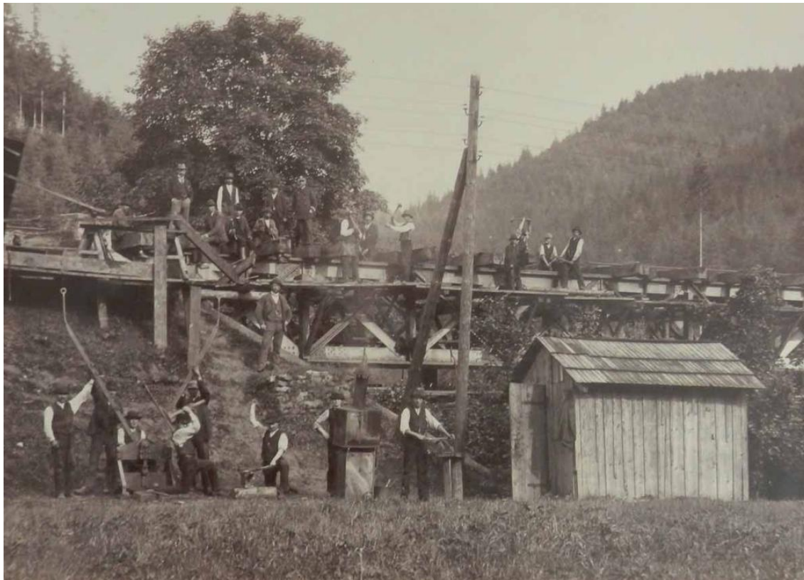
Obr. 324 Výstavba mostů realizována pracovníky Sobotínských železáren Zdroj: obec Sobotín
