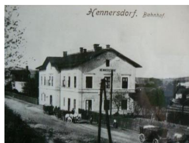
Obr. 163 Nádraží v Jindřichově zdroj: obec Jindřichov
