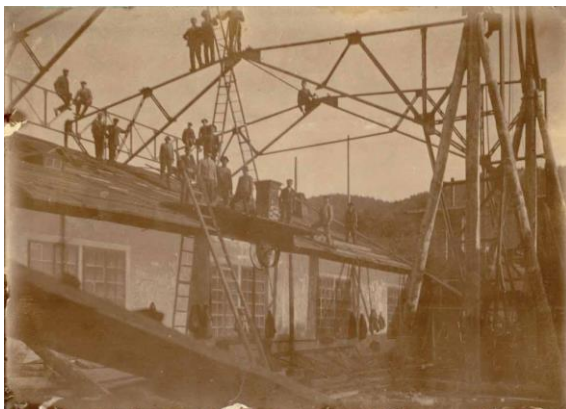
Obr. 227 Montáž velkorozponové halové konstrukce v areálu sobotínských železáren zdroj: obec Sobotín
