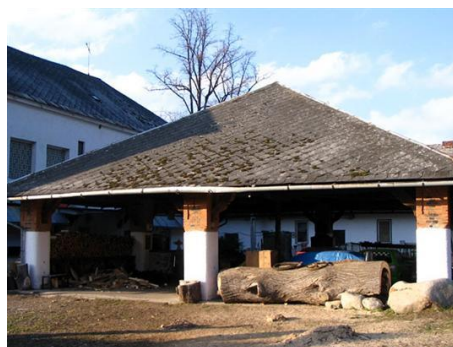
Obr. 319 Podjezdová vozovna zdroj: obec Loučná nad Desnou foto z roku 2010
