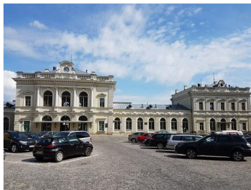
Obr. 167 Nádraží Przemysl železniční stanice Haličské dráhy stavěné mezi lety 1856-1861 zdroj: smirice.eu Levé křídlo objektu není na fotografii zachyceno.
