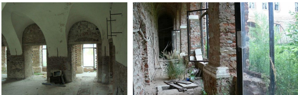
Obr. 40 Stav přízemí rok 2010
