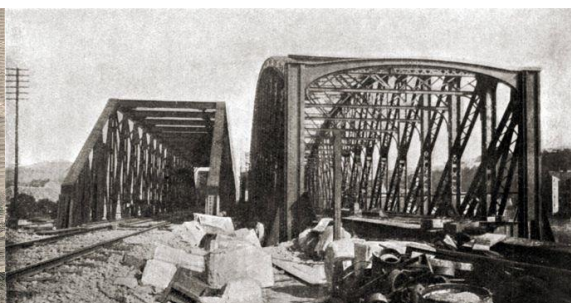
Obr. 158 Legendární přestavba železničního mostu pod Vyšehradem z roku 1901 zdroj: vysehradskej.cz Výměna železných konstrukcí se uskutečnila během jednoho dne a třetí den byl most funkční pod plnou provozní zátěží.
