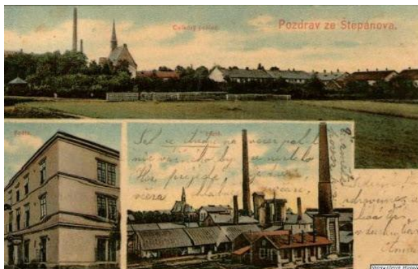
Obr. 243 Štěpánov historická pohlednice zdroj: fotohistorie.cz V horním panoramatickém snímku je vidět neogotický kostel sv. Barbory „Na Hutích“ vybudovaný v 70. letech Franzem II.
