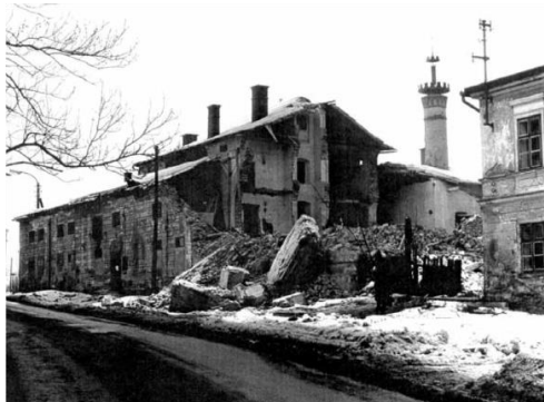
Obr. 290 Demolice objektu pivovaru v Loučné nad Desnou 70. léta 19. století zdroj: obec Loučná nad Desnou
