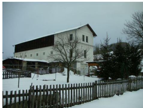
Obr. 289 Jediný dochovaný objekt z původního areálu pivovaru foto rok 2012 zdroj: vlastní fotoarchiv
