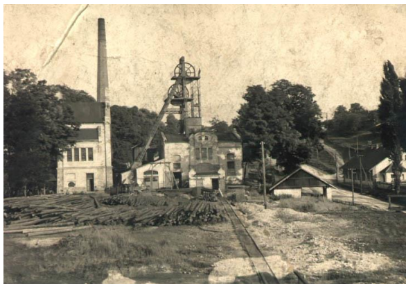
Obr. 193 Důl Františka s železnou těžební věží postavenou v roce 1904 zdroj: rosicko-oslavansko.cz
