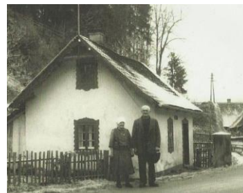
Obr. 72 Mostní mýtní stanice v Sobotíně foto z roku 1934 zdroj: Muzeum silnic ve Víkřovicích
