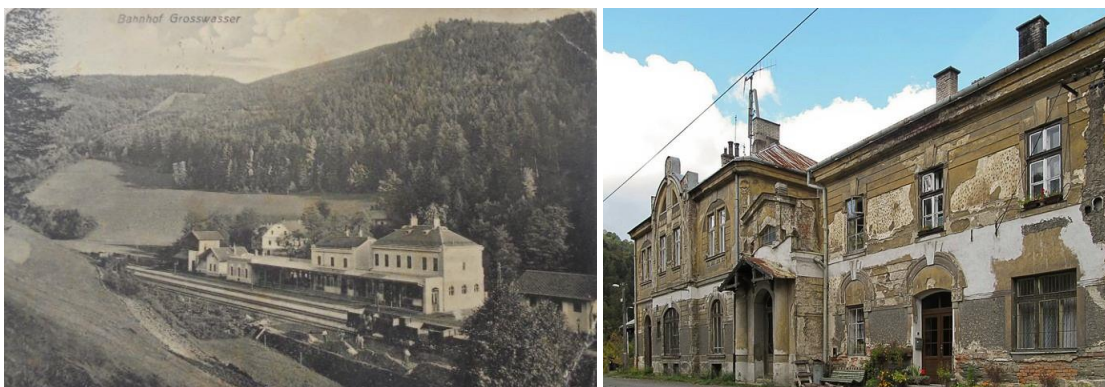
Obr. 165 Nádraží Hrubá Voda srovnání původního objektu ze 70. let 19. století a současného stavu secesně přestavěné budovy z roku 1908 architektem Gustavem Kulhavým zdroj: aukro.cz, zdroj: propamatky.cz
