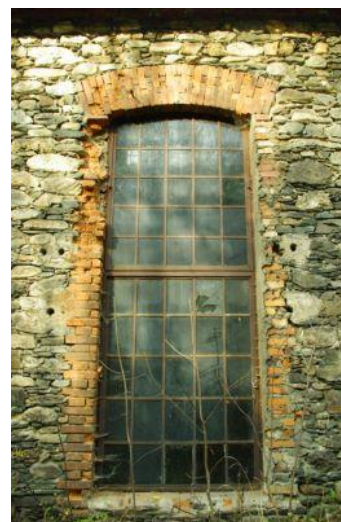
Obr. 236 Objekt Albertovy hutě v Rejhoticích stav z roku 2012 a detail segmentového zaklenutí okna s cihelným ostěním s původní smíšenou skladbou obvodového zdiva zdroj: vlastní fotoarchiv
