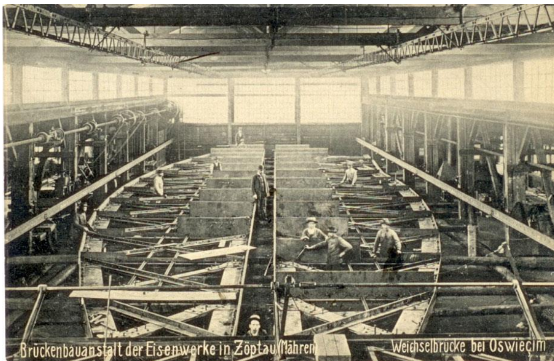
Obr. 225 Nýtovaná oblouková konstrukce mostu do Osvětimi vyrobená v sobotínských železárnách a sestavená ve specializované mostárně. Zdroj: archiv VM v Šumperku
