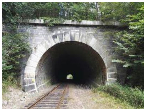
Obr. 170 Portál tunelu u obce Vlaské současný stav zdroj: moravská-pohraniční.cz
