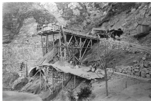
Obr. 172 Saltzkammergutbahn rok 1875 Sonnsteintunnel u Traunkirchen autor fotografie: Cruzda zdroj: austria-forum.org
