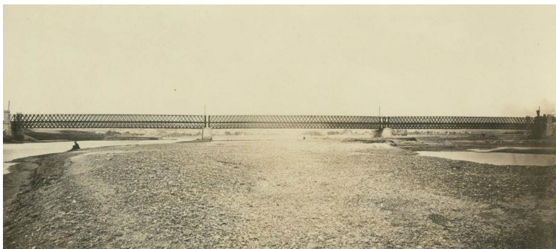
Obr. 266 Železniční most ze Schifkornových nosníků přes řeku Pruth u města Przerwa 60. léta 19. století zdroj: forgottengalicia.com
