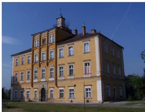
Obr. 16 Foto jižního průčelí zámku s renesančním portálem Třemešek foto rok 2012. zdroj: Památkový katalog NPÚ Celková rekonstrukce objektu po požáru v roce 2018. V majetku obce Dolní Studénky
