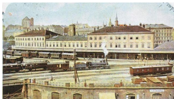
Obr. 110 Brněnské nové nádraží společností KFNB a NStB z roku 1848 pohled od kolejiště. Výřez z historické pohlednice z konce 19. st. zdroj: aukro.cz
