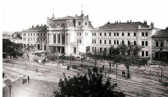
Obr. 109 Historizující fasáda a dostavba zvýšeného vestibulu z počátku 20. st. od dvojice architektů F. Uhla a J. Oehma. Podoba zachována dodnes. zdroj: zeleznicnikorydory.cz
