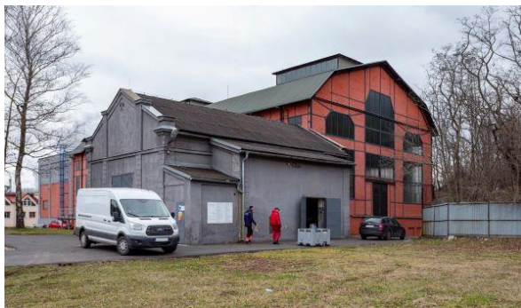
Obr. 202 Důl Hubert v Hrušově objekt staré a nové strojovny stávající stav po rekonstrukci. Foto z roku 2019 autor: Pavel Zubek
