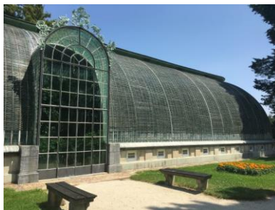
Obr. 61 Původní litinová konstrukce zámeckého skleníku v Lednici rok 2016, vyrobená v Sobotínských železárnách roku 1844 celkové pohledy a vnitřní prostor zdroj: vlastní fotoarchiv
