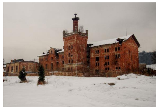
Obr. 291 Stav objektu bývalého pivovaru v roce 2017 autor: Eva Kašílková zdroj: Mizející památky
