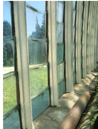
Obr. 314 Detail konstrukce s upevněním šupinových skel
