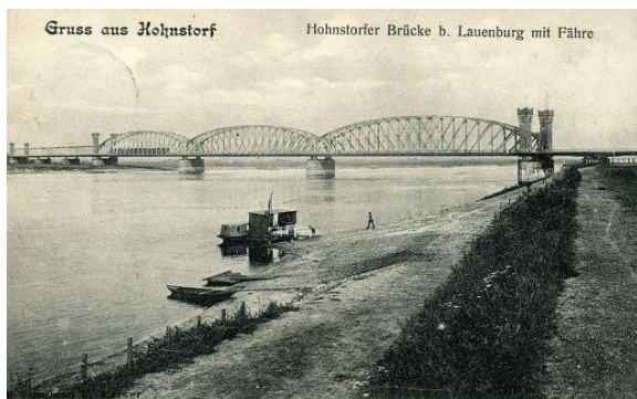
Obr. 272 Železniční most přes Labe u Lauenburgu onstrukce z roku 1877 historická pohlednice datována 1906 zdroj: wilhelm.de
