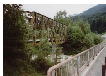
Obr. 151 Torza původních železných nýtovaných konstrukcí na trati Prince Rudolfa ve Slovinsku autor: Elmar Oberegger zdroj: oberegger2.org
