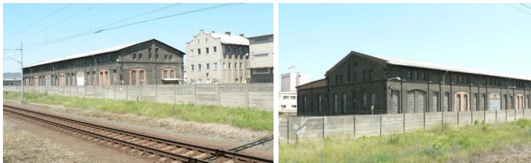
Obr. 244 Zachovalé objekty bývalých Štěpánovských železáren v areálu Armády ČR stav v roce 2013 zdroj: vlastní fotoarchiv
