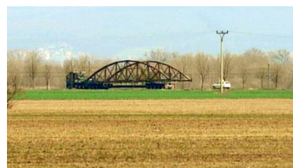
Obr. 269 Transport sneseného tělesa nýtované obloukové konstrukce vyrobené v sobotínských železárnách do Muzea silnic ve Vikýřovicích zdroj: regiony.rozhlas.cz
