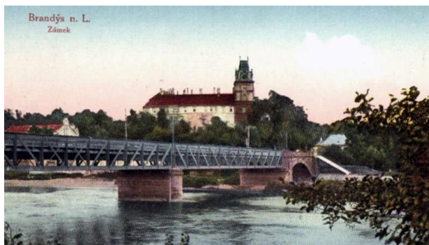
Obr. 268 Nýtovaný most v Brandýse nad Labem počátek 20.století zdroj: ceskatelevize.cz
