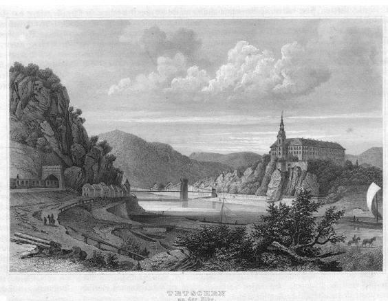
Obr. 112 Trať NStB v Podmolech, Děčín , historická reprodukce. Pohled na portál tunelu u Děčína s řetězovým silničním mostem v pozadí, na který dodávaly železné součásti sobotínské železárny bratří Kleinů, realizováno 1853-1855 zdroj: Mayers Universeum (1833-1861)
