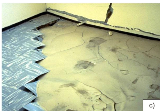
Figura 6 a) Volcanes de arena en el interior de una vivienda en Caucete. Terremoto del 23 de noviembre de 1977. b) Vista aérea de volcanes de arena alineados a lo largo de una falla o zona de debilidad. Terremoto del 23 de noviembre de 1977. Tomado de INPRES (1977). c) Volcanes de arena en el interior de una vivienda en Caucete. Terremoto del 23 de noviembre de 1977. Tomado de Volponi et al. (1978). d) Detalle de volcanes de arena formados durante el terremoto de 1977. Tomado de INPRES (1977).
