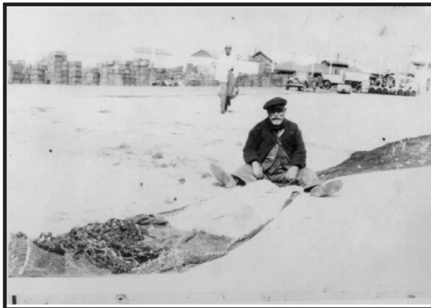
Foto 17. Redero trabajando en la banquina (Gentileza MHP.)
