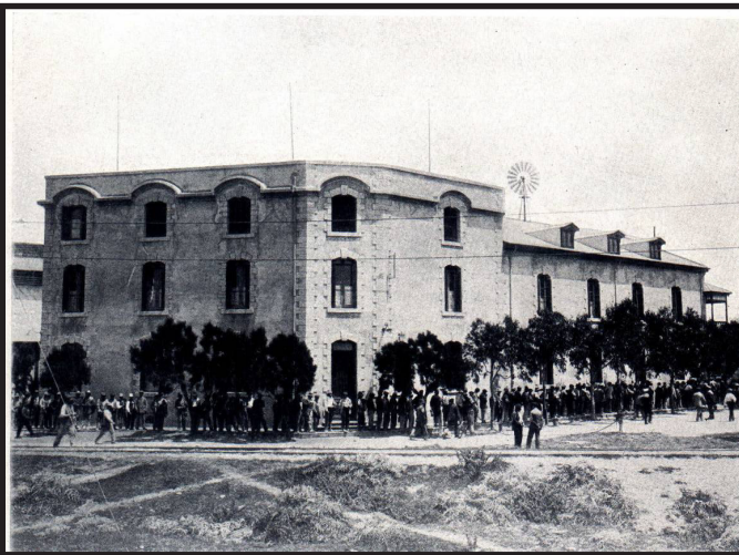
Foto 11. La “Casa de la Empresa” 20 .
