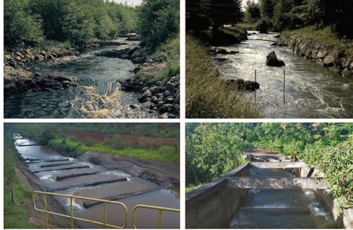
Figura 2. Canal de "piracema" construido en Itaipu presentando alta complejidad morfológica e hidrológica para facilitar el pasaje de peces (Fotos: Claudio Baigún).
