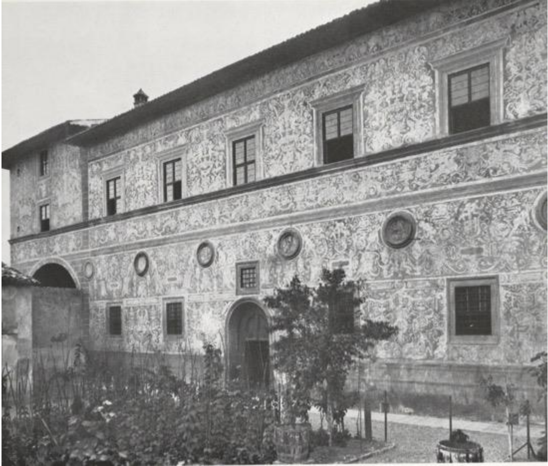
Fig. 14: Palazzo Vitelli alla Cannoniera, Citta di Castello, Perugia, Italy (1534), by Cristofano Gherardi Garden front.
