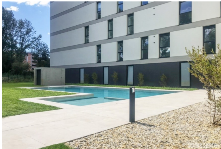
Figura 6 - Lote A7.2 - Condomínio Fechado
