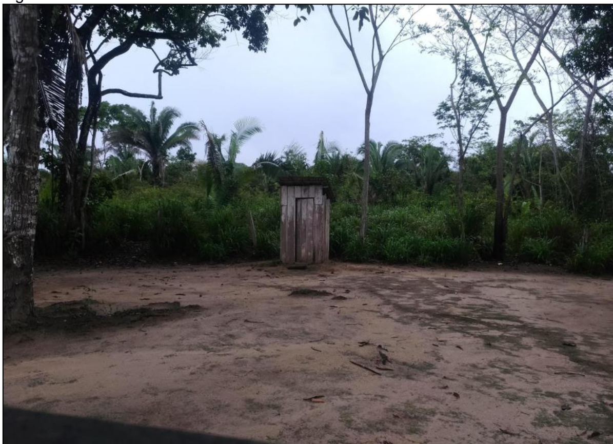
Figura 9 – Banheiro da escola Paulo Freire
