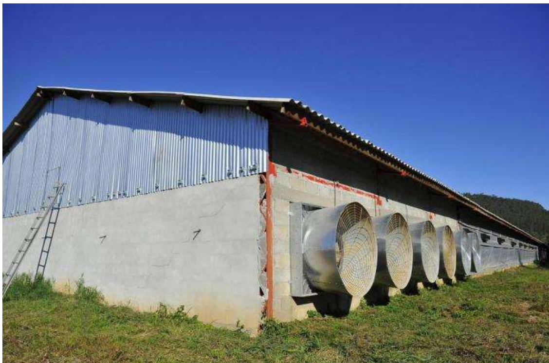
Figura 2 - Sistema de ventilação em túnel nas laterais do galpão.
