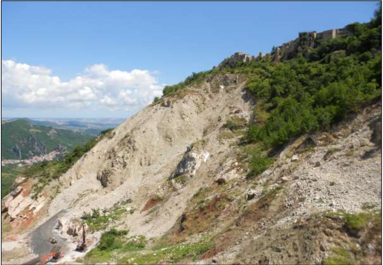
Figura 6 – La frana di Montebello sul Sangro in fase di consolidamento. A monte, l'antico borgo di Buonanotte oramai abbandonato. Fotografia dell'autore, luglio 2019.
