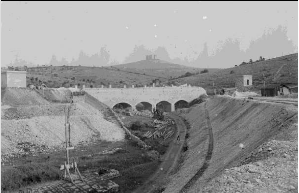
Figura 62 – La posizione dominante del Castel del Monte sull’altipiano murgiano in una foto degli anni Cinquanta, scattata verso sud in occasione dei lavori di realizzazione del Canale Macenzano dell’Acquedotto pugliese. Fotografia fornita da Acquedotto Pugliese S.p.A., azienda proprietaria dell’immagine.
