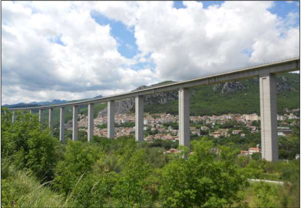
Figura 58 – Il viadotto della S.S. 652 “Fondo Valle Sangro” in un’immagine scattata verso ovest. Oltre il viadotto, la cresta del Monte Vecchio e il centro abitato di Villa Santa Maria. Fotografia dell’autore, agosto 2019.
