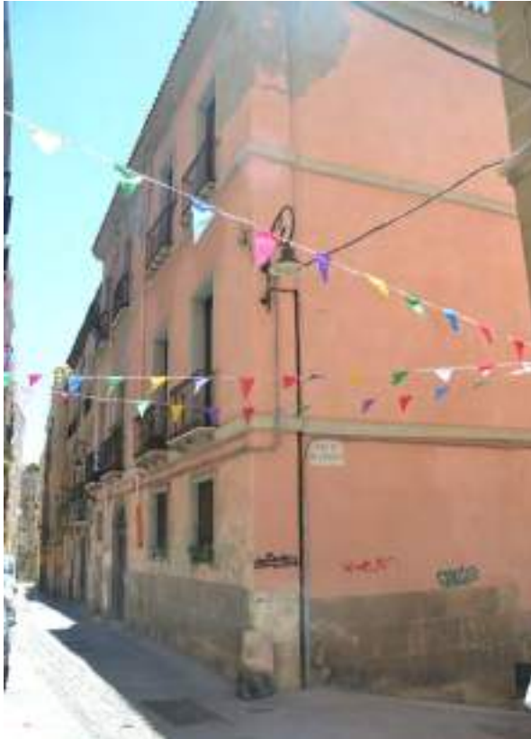
Figura 6.14.5.2 Edificio di Via Genovesi in cui visse Giovanni Falconi con la sua Famiglia. Nei documenti d'archivio del Comune di Cagliari, riguardanti i primi censimenti dell'Ottocento (1857), l'abitazione viene annotata come 'Casa Boi' al posto del numero civico, che evidentemente non c'era. Allo stato attuale delle ricerche non conosciamo il motivo del riferimento al cognome Boi, né se avesse un qualche collegamento con il suo maestro Prof. Boi. I coniugi Falconi e i loro sei figli abitavano con una domestica di 23 anni, Vittoria Morgini. Fotografia di Marcello Trucas.
