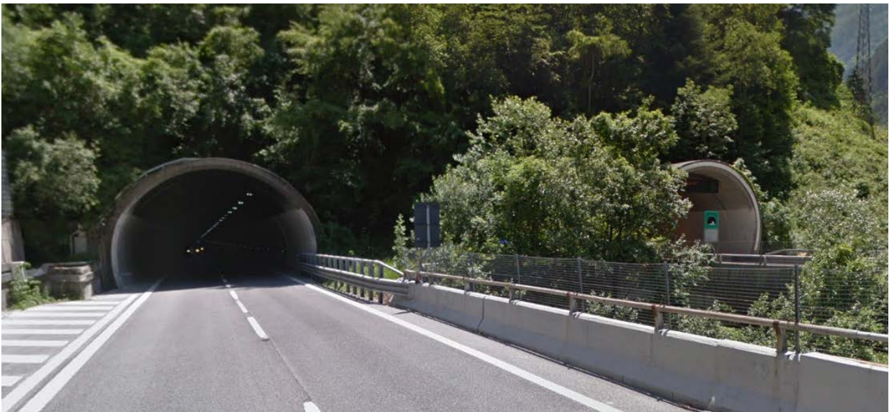
Figura 89: imbocco NORD della canna SUD
