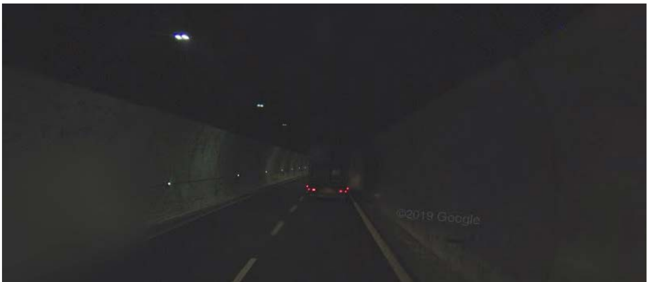
Figura 87: Vista interna canna direzione NORD
