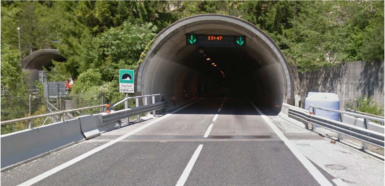
Figura 88: imbocco SUD della canna NORD
