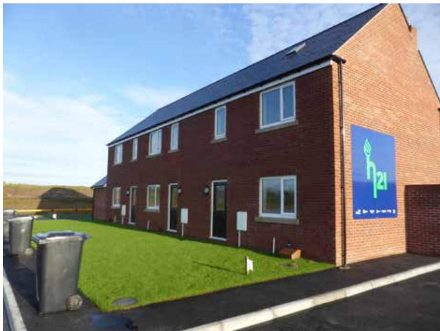
Figuur 8. Onderzoekswoningen op de site van DNV GL in Spadeadam als onderdeel van het H21-initiatief
