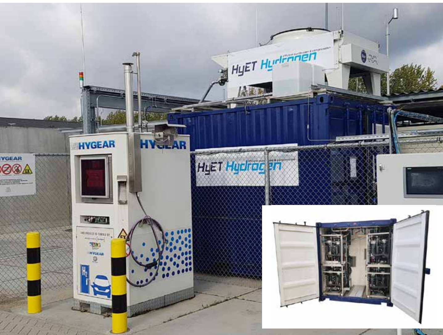
Figuur 4: Containerized EWC-systeem 120 kg/d (450 bar) ontworpen voor een Waterstof Tankstation
