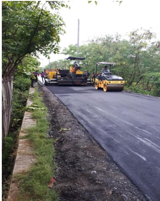
Gambar 6. Proses Pemasatan Aspal
