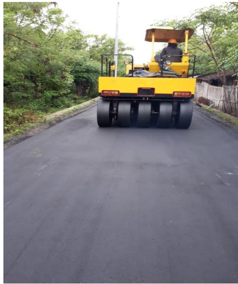
Gambar 5. Proses Pemasatan Aspal
