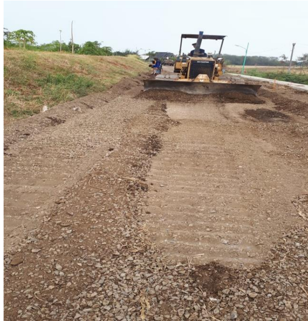
Gambar 1. Pembersihan Lahan Dengan Alat Bulldozer
