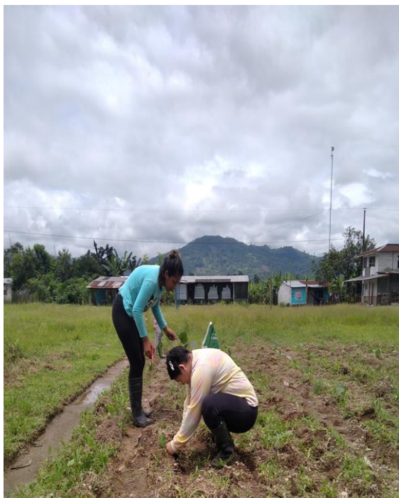
Fotografía 1. Limpieza del terreno
