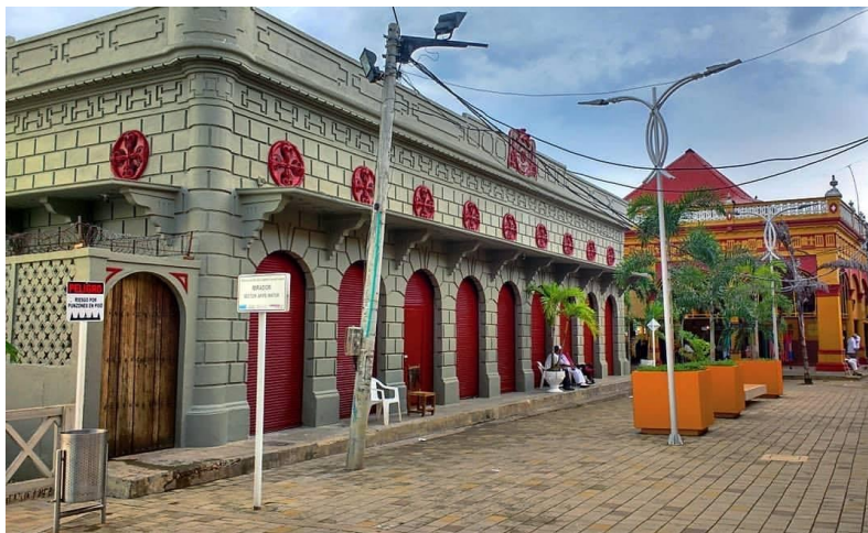
Figura 21. Edificio Afife Matuk remodelado Fuente: propia, año2019
