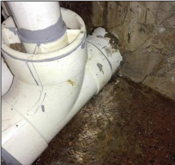
**Figura 46:** Fuga en las paredes de la cámara de filtración del FLA. Fuente: Autoría propia.
