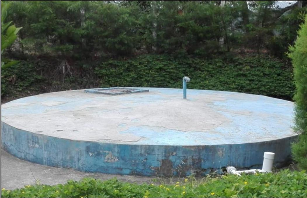
**Figura 34:** Tanque de almacenamiento semienterrado con capacidad de 36.30 m<sup>3</sup>. Fuente: Autoría propia.
