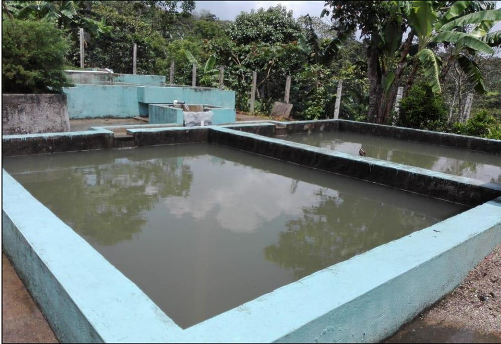
**Figura 32:** Filtro Lento de arena (FLA), en la toma se observa las cámaras de filtración y la unidad de entrada. Fuente: Autoría propia.
