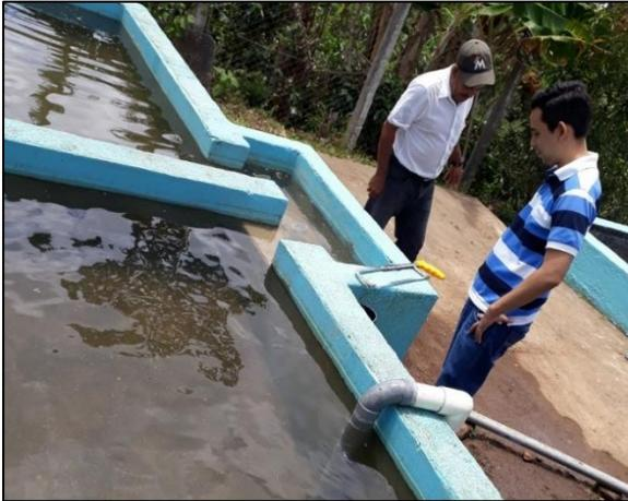
**Figura 54:** Recolección de muestra del lecho filtrante del FGAC. Fuente: Autoría propia.
