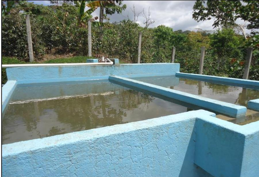
**Figura 31:** Vista frontal del FGAC, se puede observar ambas cámaras de filtración trabajando en paralelo. Fuente: autoría propia
