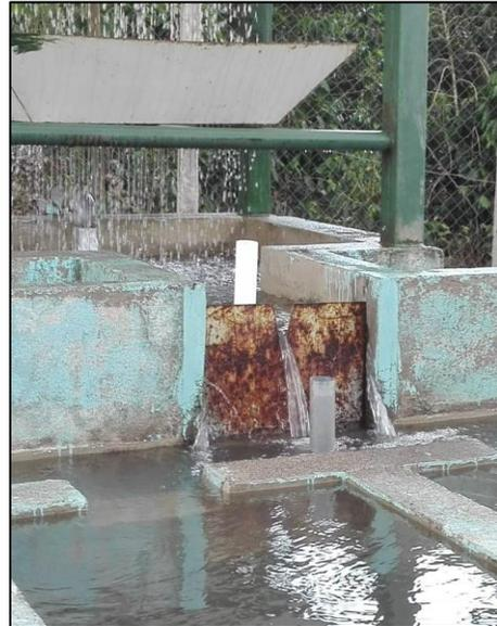
**Figura 40:** Fugas alrededor del perímetro de los vertederos del FGDI, provocando errores en la medición. Fuente: Autoría propia
