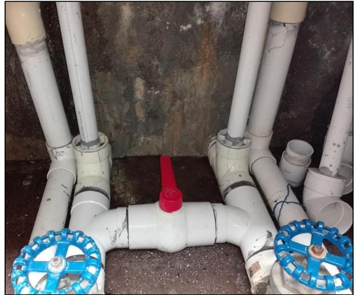
**Figura 47:** Vista completa de la fuga en las paredes de la cámara de filtración del FLA, por deficiencia en el sellado de dicha pared. Fuente: Autoría propia.
