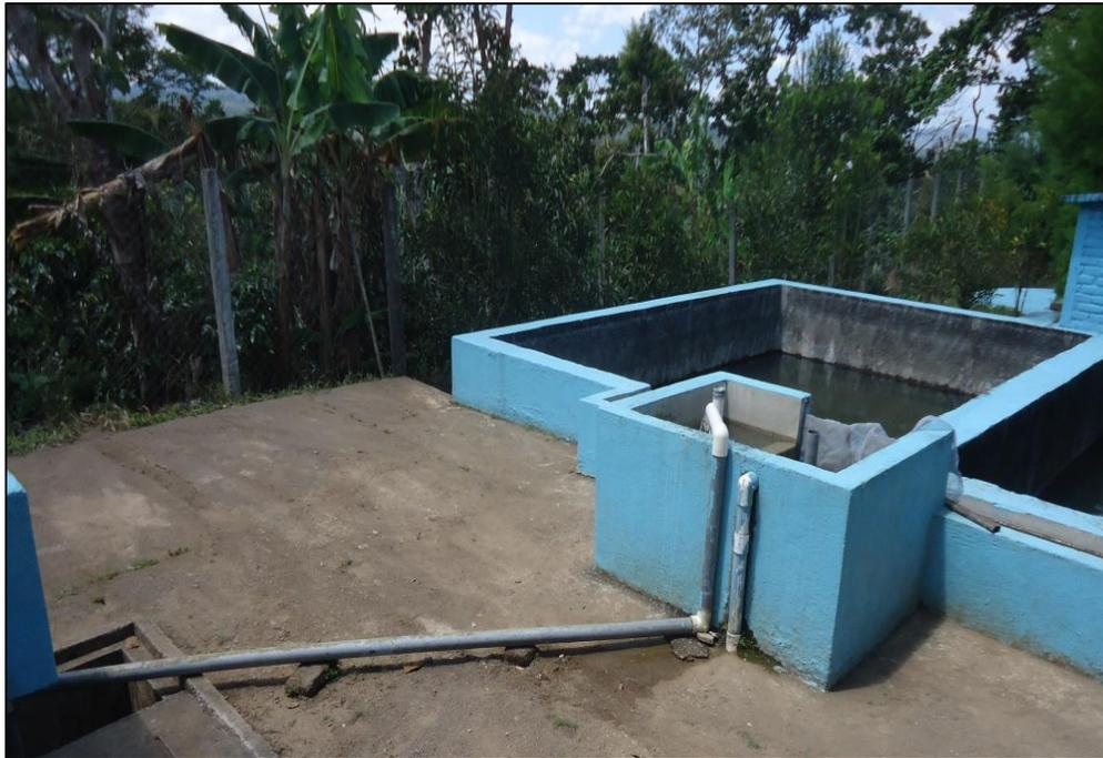
**Figura 44:** Tubería anexa saliendo del FGAC a la entrada del FLA. Fuente: Autoría propia.
