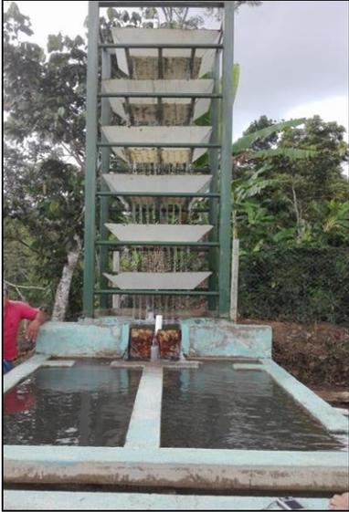
**Figura 27:** Vista frontal del Filtro grueso dinámico, en donde se puede observar ambas cámaras de filtración.
