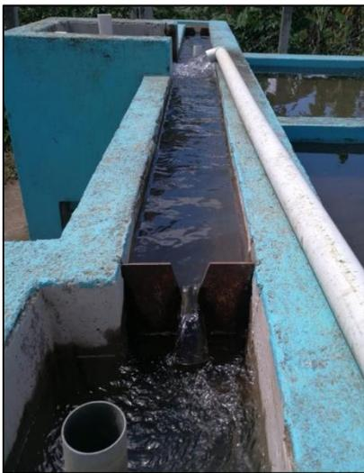
**Figura 41:** Descarga del efluente del FGDI directamente a los canales de distribución del FGAC. Fuente: Autoría propia.
