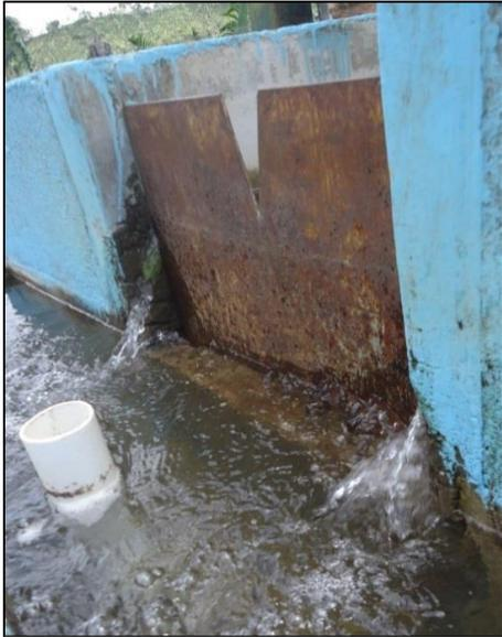
**Figura 39:** Fugas alrededor del perímetro de los vertederos del FGAC, provocando errores en la medición. Fuente: Autoría propia
