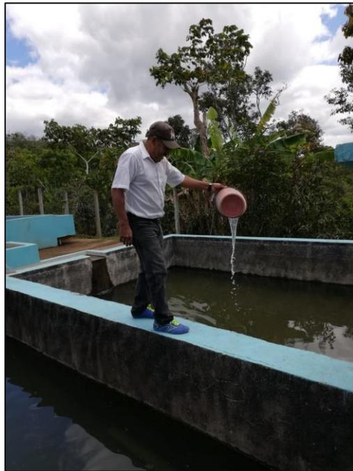
**Figura 49:** Operador de la planta aplicando erróneamente una solución de cloro granular sobre el filtro lento de arena. Fuente: Autoría propia.
