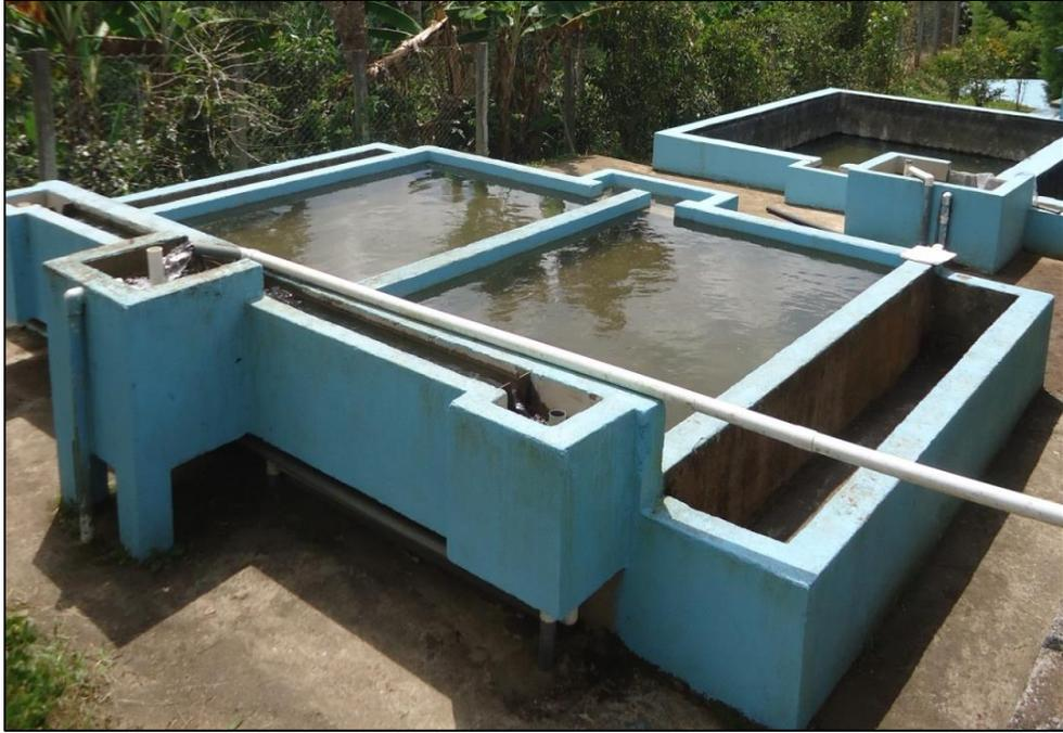
**Figura 43:** Tuberías anexas sobre el FGAC, descargando directamente a la entrada de este. Fuente: Autoría propia
