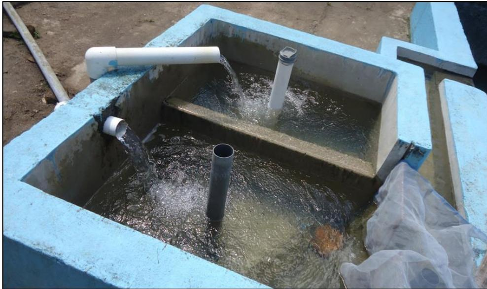
**Figura 45:** Descarga directa sobre el vertedero de rebose del FLA.
