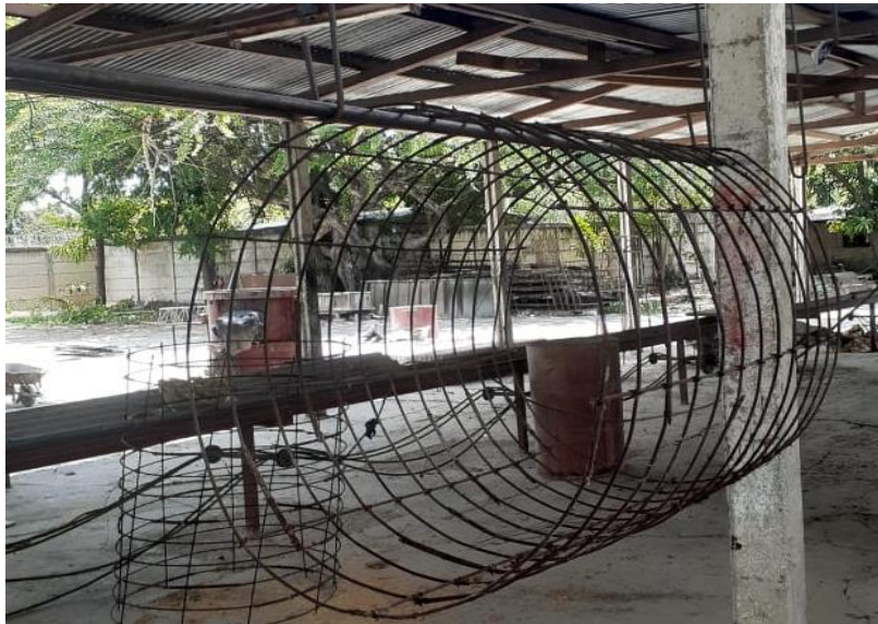
Ilustración N° 6: Armazón de acero de refuerzo.
