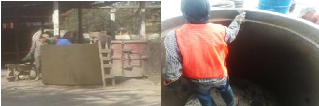
Ilustración N° 14: Albañiles mejorando el acabado del TCR.
