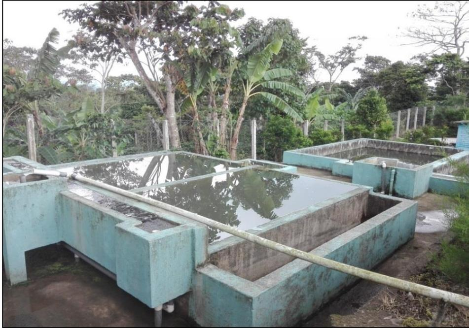
**Figura 28:** FGAC en donde se aprecian la mayoría de los componentes como: canal de distribución, cámara de entrada y cámaras de filtración. Fuente: Autoría propia.
