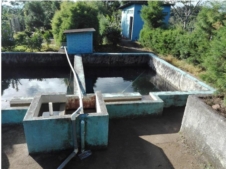
**Figura 48:** El FLA se encuentra fuera de funcionamiento por fugas en las paredes de la cámara de filtración, ocasionando que se saltaran esta etapa del tratamiento. Fuente: Autoría propia.
