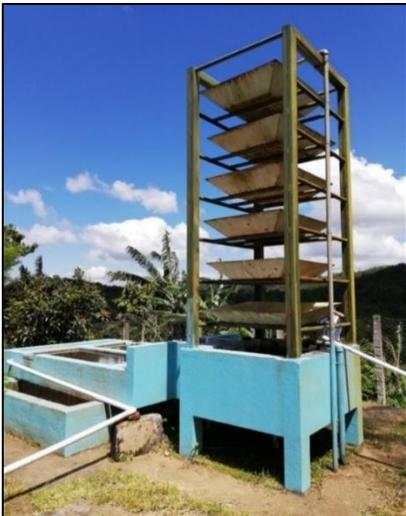
**Figura 29:** Filtro grueso Dinámico tiene los siguientes componentes: cámara de entrada, cámara de lavado de gravas y cámara de filtración. Fuente: Autoría propia.
