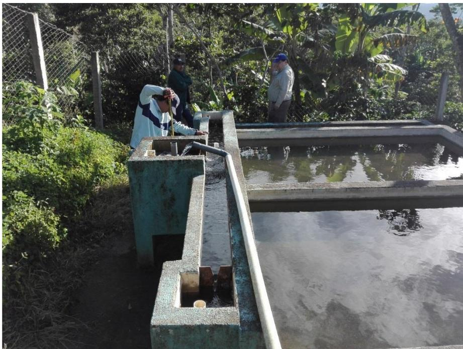
**Figura 61:** Tomando las dimensiones del FGAC, en conjunto con el levantamiento topográfico. Fuente: Autoría propia.
