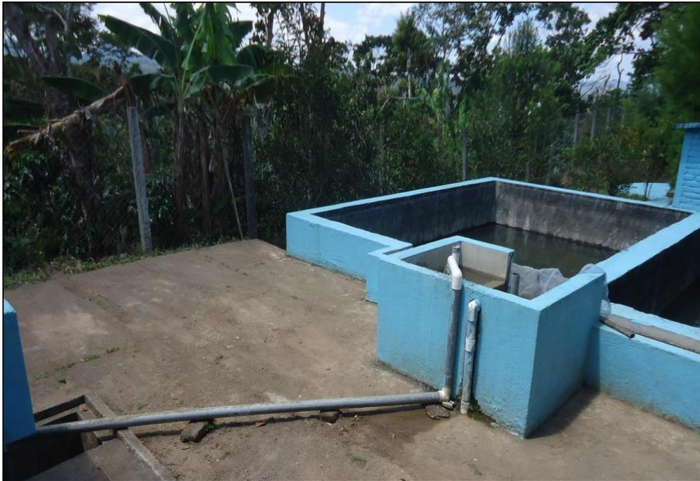
**Figura 44:** Tubería anexa saliendo del FGAC a la entrada del FLA. Fuente: Autoría propia.
