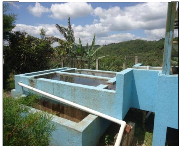
**Figura 42:** Tuberías anexas en el FGDI, por fallas en el diseño de las tuberías de conducción. Fuente: Autoría propia
