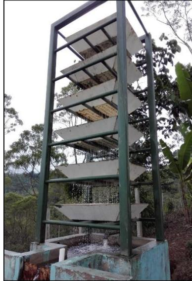
**Figura 28:** Aireador en la entrada de la planta existente. Fuente: Autoría propia.
