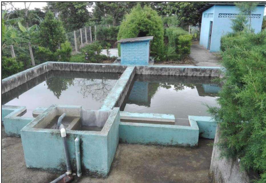
**Figura 33:** Vista posterior del FLA, en donde se observa las tuberías de ingreso, la unidad de entrada, los canales de distribución y ambas cámaras de filtración trabajando en paralelo. Fuente: autoría propia.
