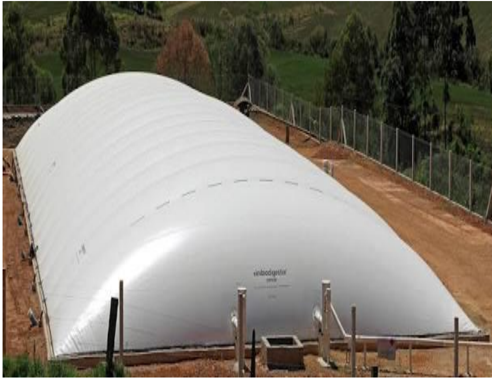
Ilustración 2: biodigestor laguna cubierta
