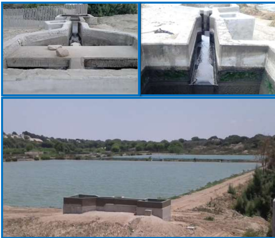
Figura N° 05: Canaleta de Captación
