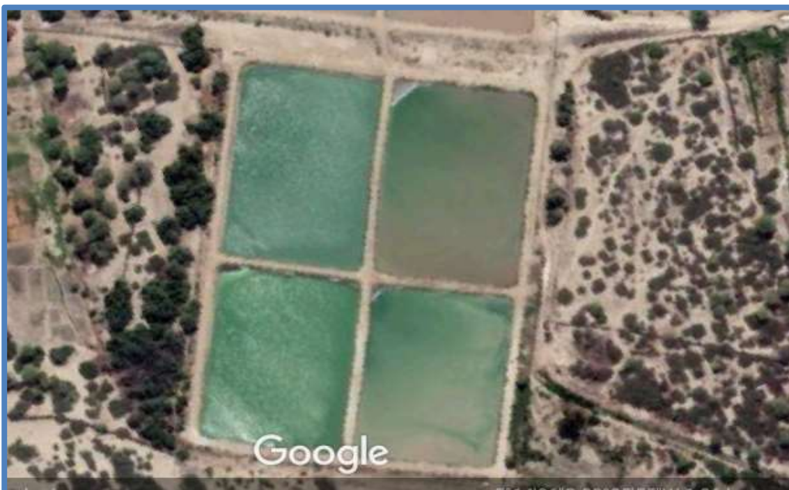
Figura N° 04: Vista del Sistema de Tratamiento Rehabilitado El Indio
