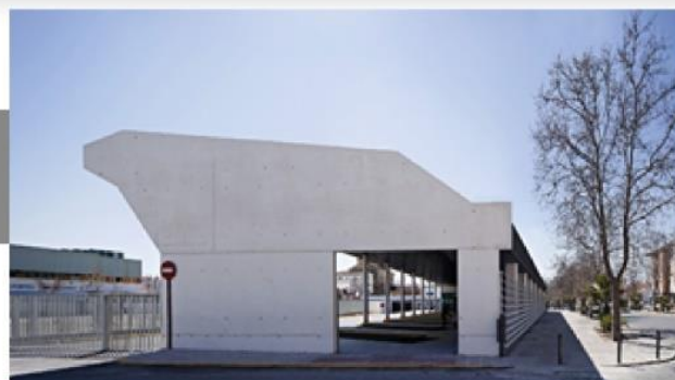
Fotografía, Fachada Lateral, Estación de autobuses de Baeza. Autor: Javier Callejas.
