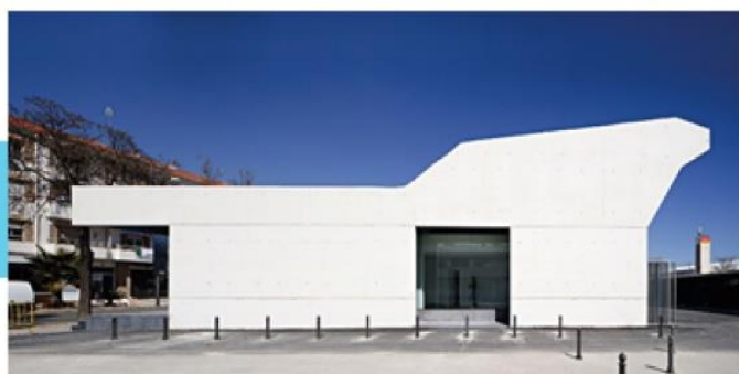
Fotografía, Fachada Lateral, Estación de autobuses de Baeza. Autor: Javier Callejas.
