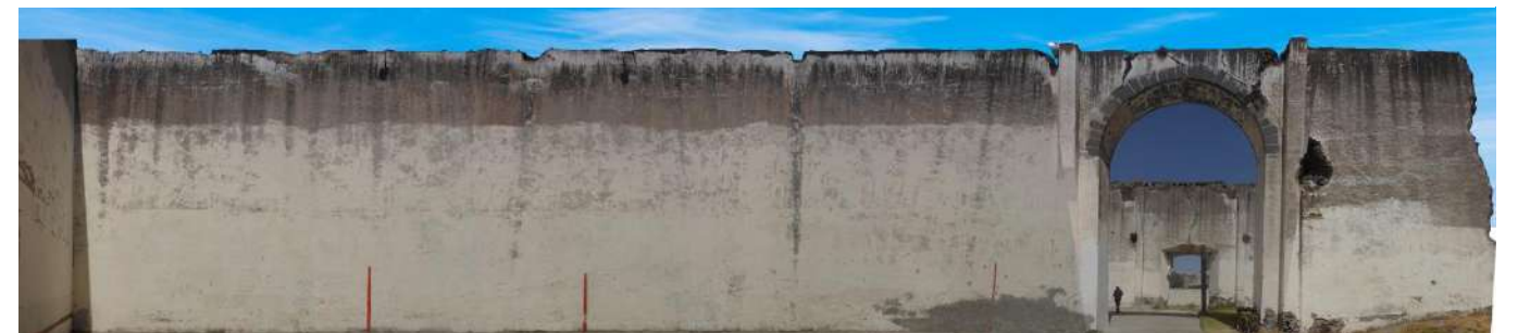
Figura 33. Muro interior norte, troje sur.
