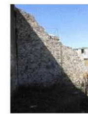
11 Muro p sur este Oeste, vista exterior de patio.
