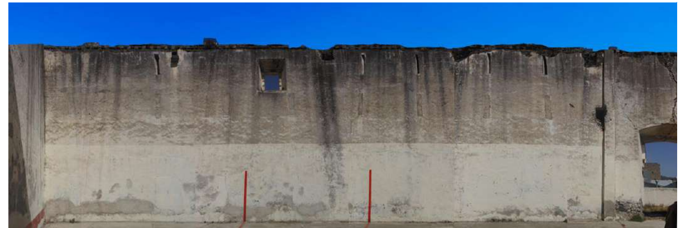
Figura 32. Muro interior norte, troje norte,
