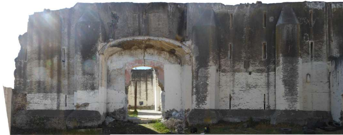
Figura 28. Muro exterior norte, troje norte.
