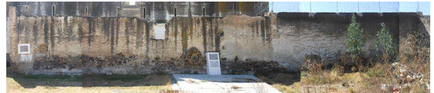
Figura 26. Muro exterior norte, Anexo.
