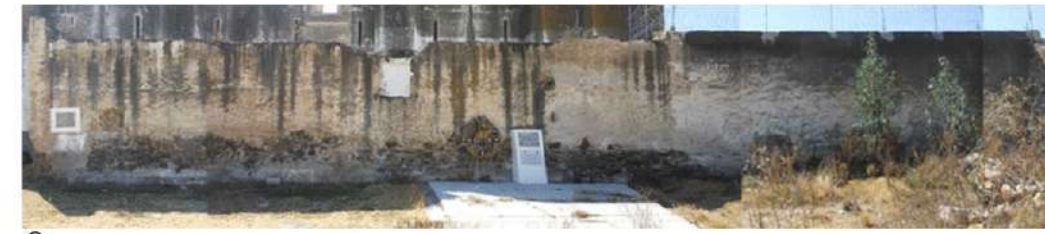
10 Nueva fachada de anexo.
