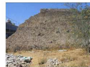
12 Muro par este Oeste, vista interior de patio.
