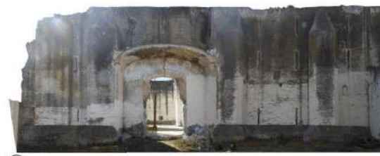
2 Vista Sur, interior patio.
