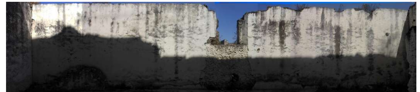
Figura 27. Muro interior norte, Anexo.
