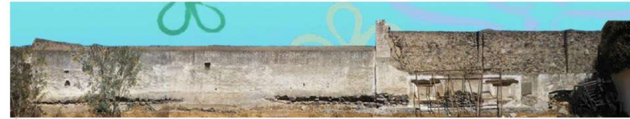
13 Muro Norte, interior patio.
